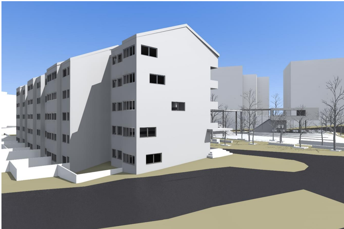
Figura 66 – Novos pontos de contacto entre exterior e interior. Bloco 3
