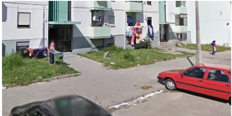
Figura 36- Entradas de blocos e percursos pedonais com presença de lixo casual
