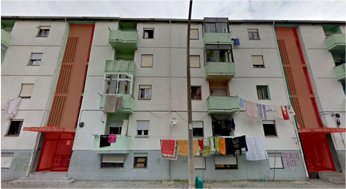
Figura 44 – Indicação a vermelho dos elementos verticais a demolir nas entradas comuns dos edifícios
