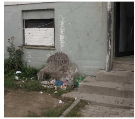
Figura 42 - Vandalismo e lixo acumulado
