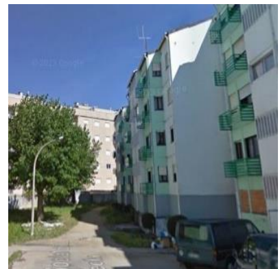
Figura 38 - Lixo casual e vandalismo
