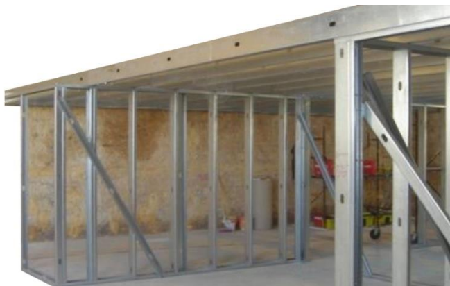
Figura 148 – Furações para passagem de cabos
