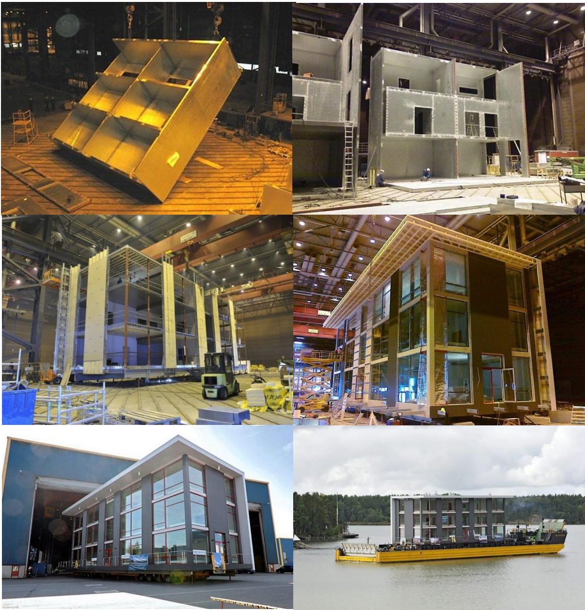
Figura 18 – Fase inicial da construção do edifício móvel da empresa Neapo Oy
