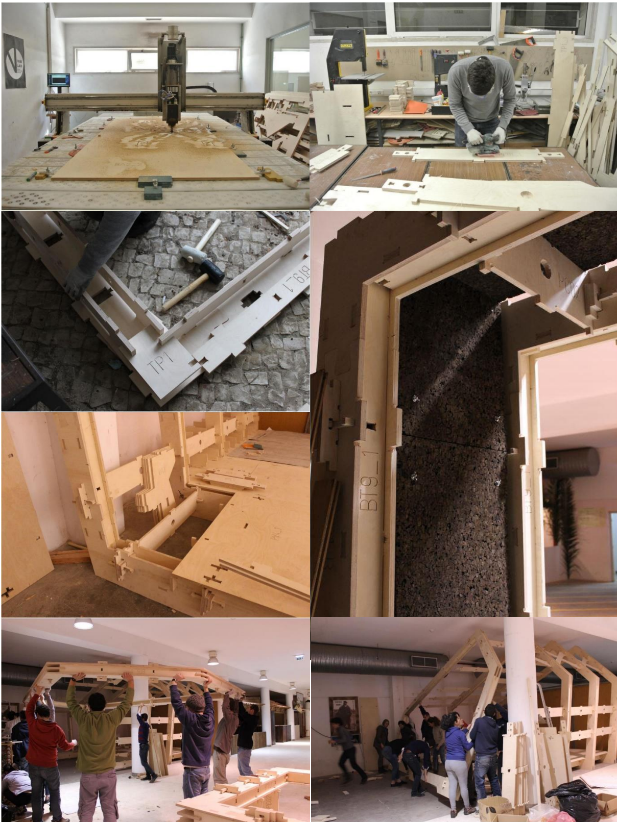
Figura 41 – Corte de peças Figura 42 – Aperfeiçoamento das peças Figura 43 – Montagem da estrutura Figura 44 – Colocação das placas de madeira Figura 45 – Introdução de aglomerado negro de cortiça neste Figura 46 – Início da montagem de uma estrutura Figura 47 – Estrutura a ser finalizada
