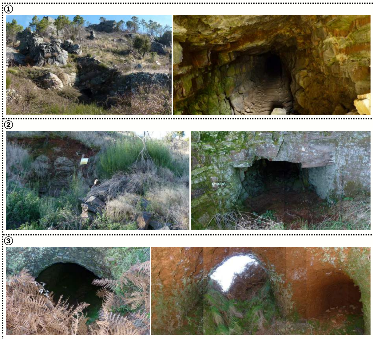
Figura 84: Levantamento topográfico das galerias do Cabeço da Mua. Registos fotográficos das entradas das galerias - aproximação e pormenor interior.
