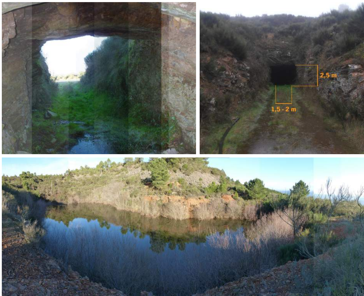
Figura 80: Registos fotográficos da entrada Norte da galeria da Carvalhosa e bacia de retenção onde a mesma desemboca.
