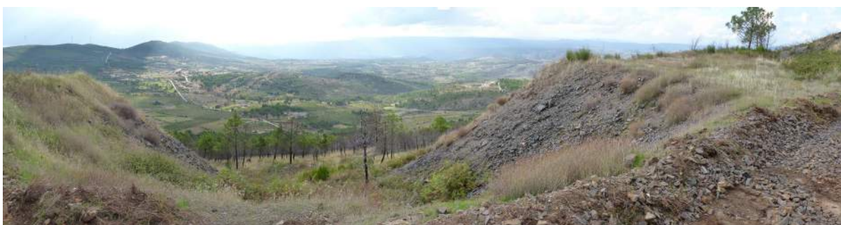
Figura 72: Escombreira do Cabeço da Mua.
