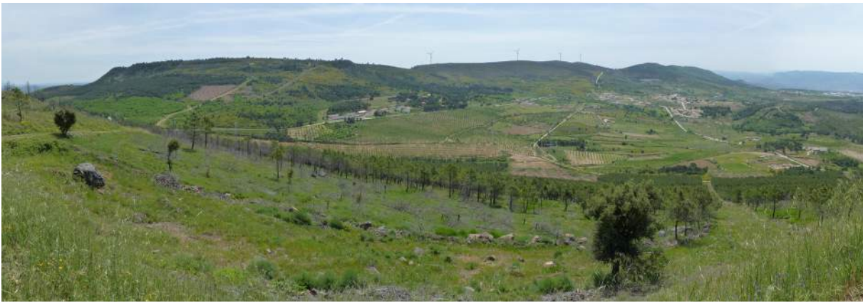
Figura 17: Registo fotográfico demonstrando a robustez topográfica da Serra do Reboredo relativamente à sua envolvente, morfologia definida continuamente ao longo do tempo (vista Norte, a partir do topo do Cabeço da Mua).
