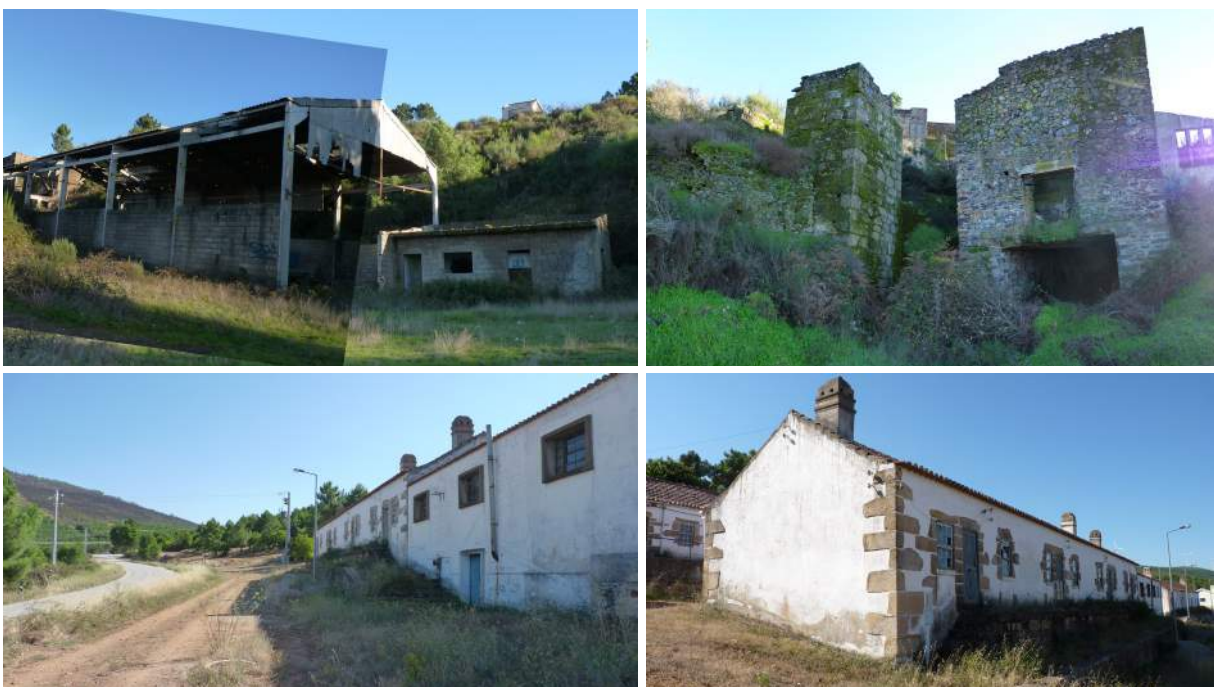
Figura 70: Edificado em estado de abandono no alto e na base da Carvalhosa, junto à EN 220.
