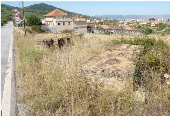
Pesquisas: Instalações da antiga Ferrominas, junto à EN 220 | Evidência presente, pela afirmação das sapatas, da desmantelada estrutura de proteção da EN 220, sobre a qual no passado decorreu o transporte aéreo do minério de ferro | Registo fotográfico retirado de (PARM, "Catálogo")
