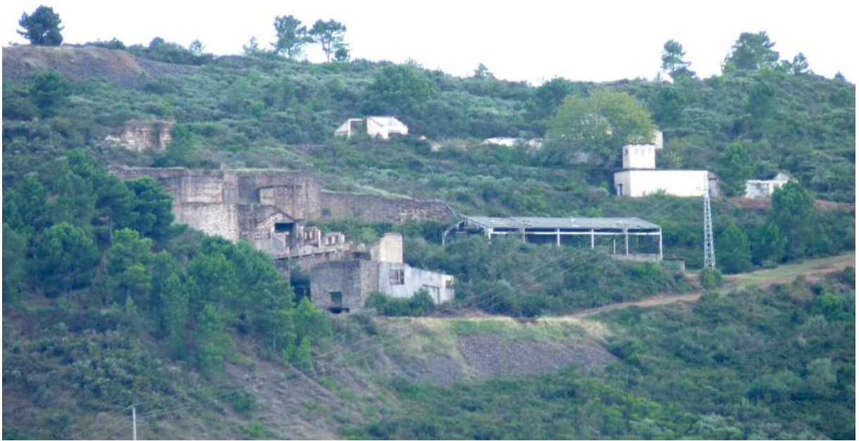
Figura 77: Edifícios em elevado estado de ruína no topo da Carvalhosa.
