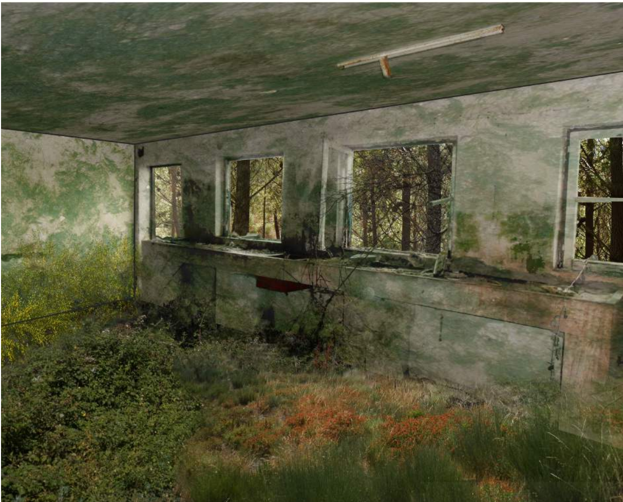
Figura 122: Fotomontagem demonstrativa do momento presente (direita) e da interpretação do hipotético futuro proposto de uma perspectiva interior.
