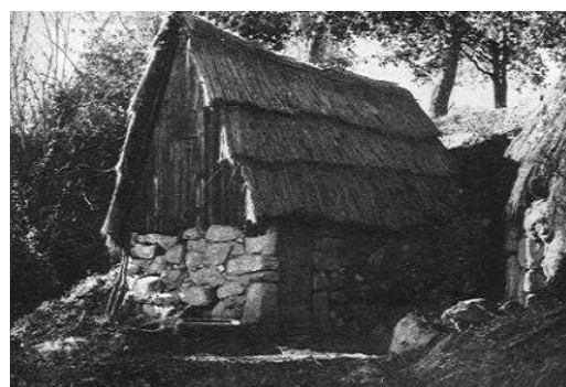
Figura 34. Habitação primitiva de pedra e materiais vegetais, de planta retangular: Choupana de cobertura de duas águas em Prime, Viseu
