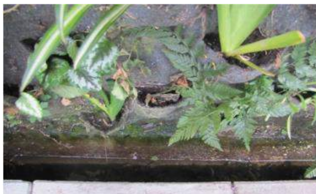
Figura 11. Bolsas efetuadas nas mantas absorventes nas Natura Towers, Portugal.
