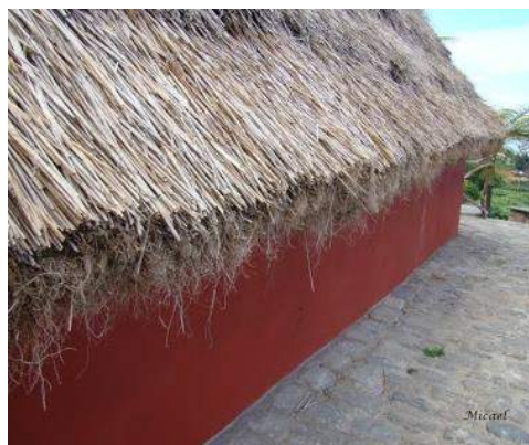
Figura 40. Aproximação a cobertura de casa de Meio Fio
