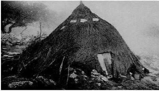
Figura 35. Habitação primitiva do tipo cobertura-parede em materiais vegetais de planta circular: Choça em Beirã, Marvão
