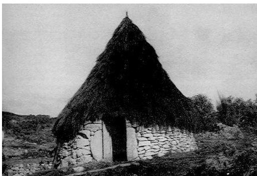
Figura 33. Habitação primitiva de pedra e materiais vegetais, de forma cilindro-cônica: Cabana de dois pisos em Abrunhosa, Mangualde
