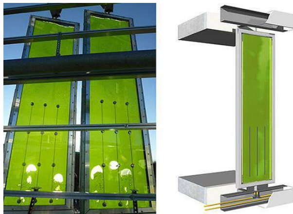
Figura 30. Construção de Fachadas Bio- Reativas
