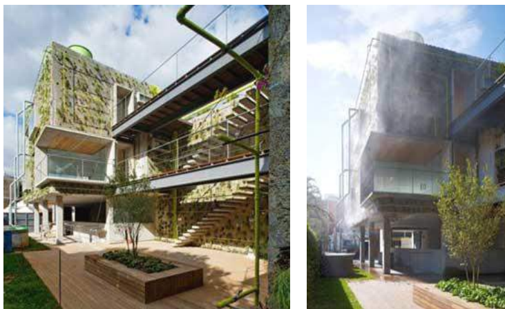
Figura 22. Sistema por vaporização no Edifício Harmonia 57, em São Paulo
