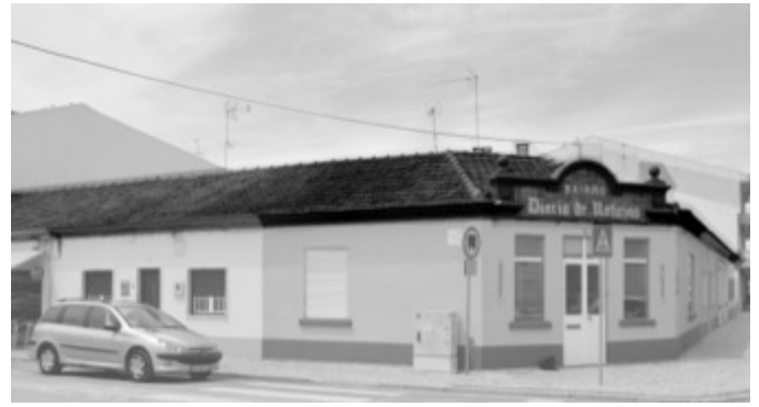
Figure 7. Continuous cornice in Bairro das Notícias, Benavente. (Credits: CI-ESG).
