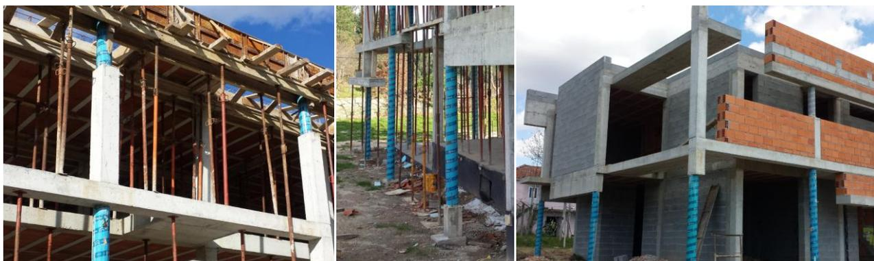
Figura 44 Representação dos pilares circulares de forma otimizada (a) - esquerda, (b) - central e (c) - direita.
