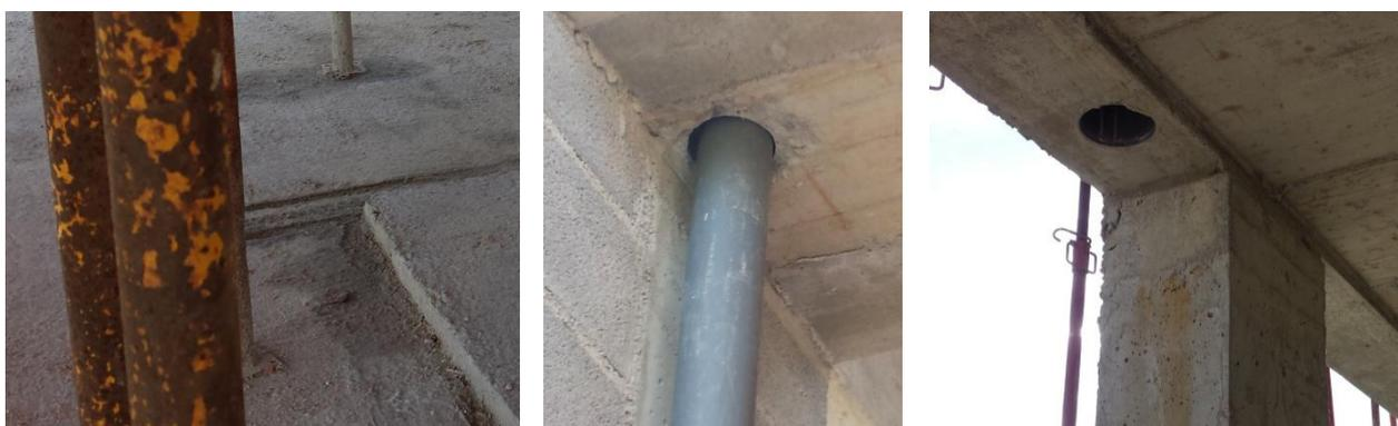
Figura 43 (a) Desnível do pavimento (esquerda), (b) e (c) Negativo para águas residuais (central e direita, respetivamente).
