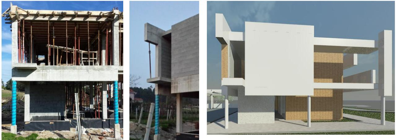
Figura 45 Representação do erro construtivo executado em obra, (a) representação inicial (esquerda), (b) representação final corrigida (central) e (c) representação digital do modelo (direita).
