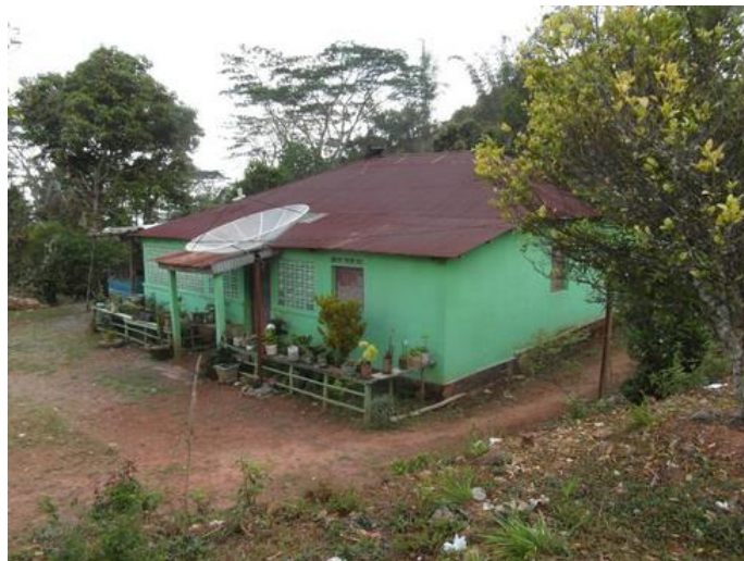
Figura 49 – Tipo de construção de casa atual em Timor Leste
