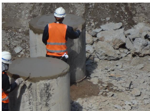
Figura 50 – Fundações da Ponte Comoro II com uma classe de betão na ordem do C25/30
