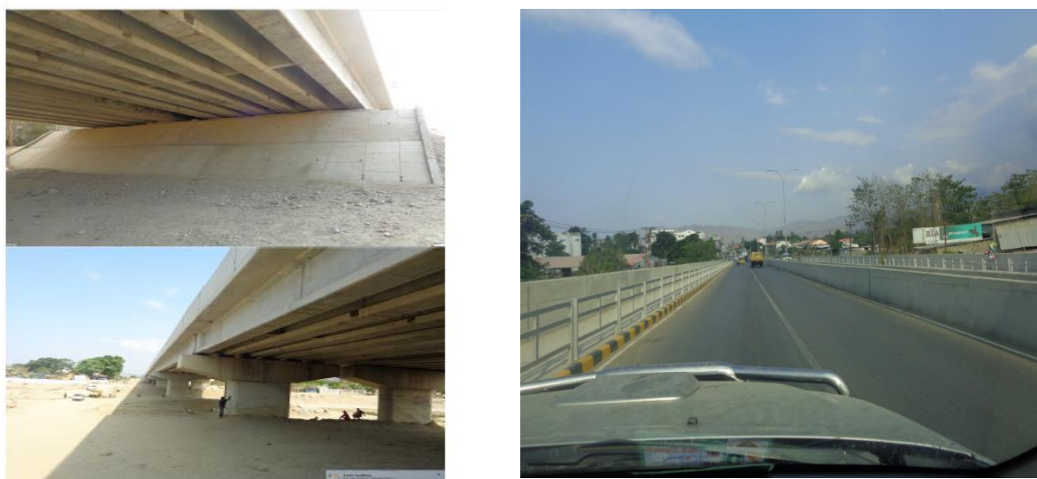
Figura 54 – Ponte Comoro esta finalizada com partes em betão [55]
