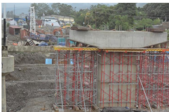
Figura 51 – Exemplo do uso duma classe de betão C 50/60 nos pilares da Ponte Comoro II
