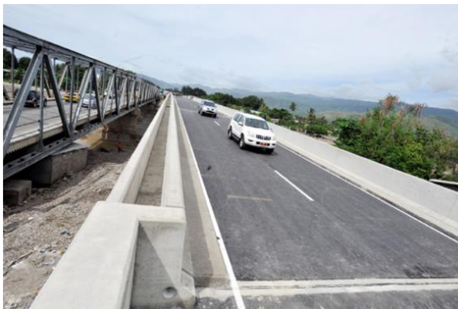
Figura 53 – Ponte Comoro quase finalizada com partes em betão [55]
