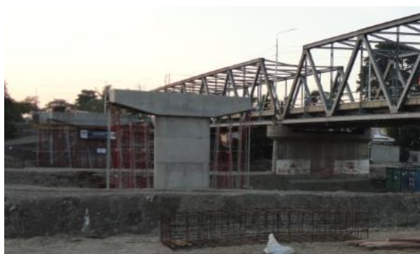
Figura 51 – Exemplo do uso duma classe de betão C 50/60 nos pilares da Ponte Comoro II
