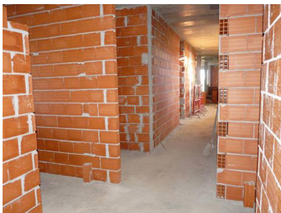
Figura 76 - Parede divisória com tijolo furado (in http://www.engenhariacivil.com/imagens/interior-paredes-tijolo.jpg )
