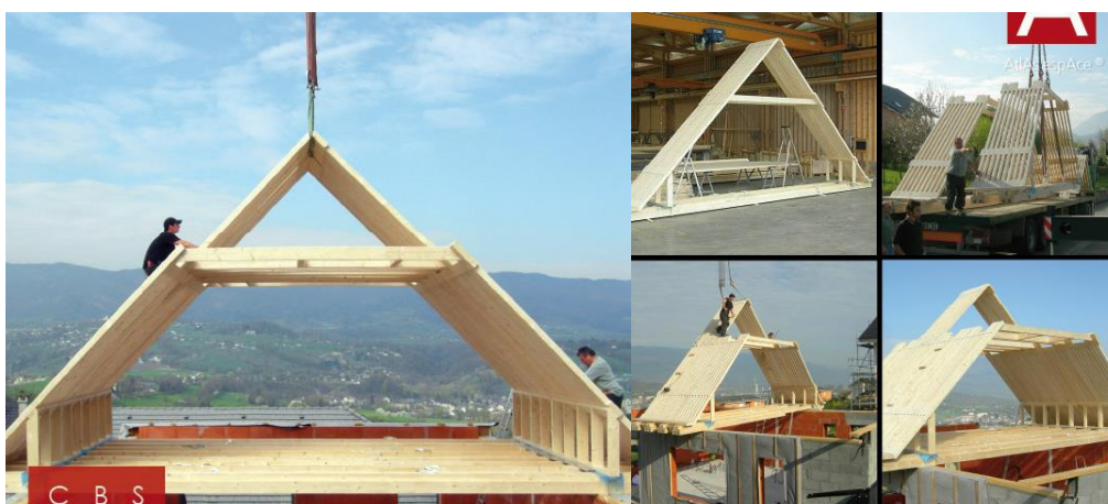
Figura 94 - Montagem, transporte e colocação de uma cobertura “Véga” (in CBS-CBT)
