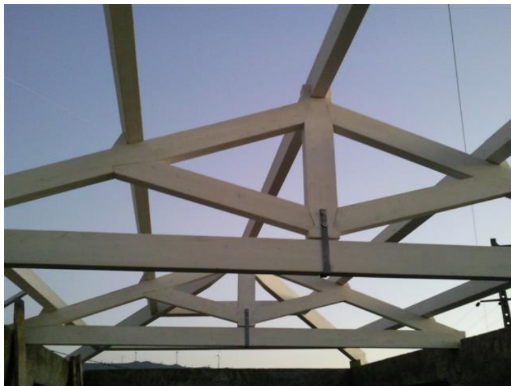
Figura 46 - Constituição da estrutura de cobertura (in www.tecniwood.pt )
