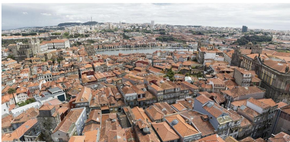
Figura 45 - Diversidade de tipologias de coberturas (in www.portopatrimoniomundial.com )
