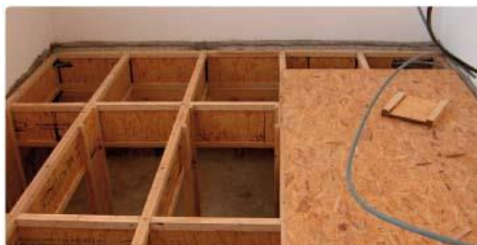
Figura 7 - Exemplo de aplicação dos painéis OSB (in www.jular.pt)
