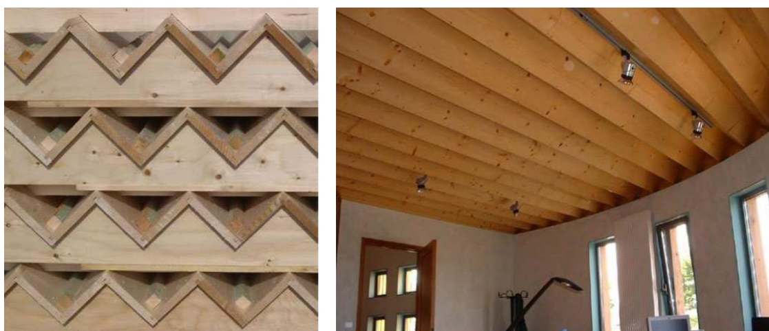
Figura 67 - Peça do sistema “ Wenus ” e aspeto final do teto produzido pelo sistema (in CBS-CBT)
