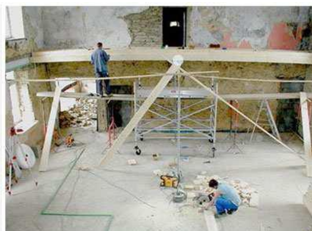
Figura 23 - Aplicação do sistema O'Portune na reabilitação de uma habitação (in www.cbscbt.com )
