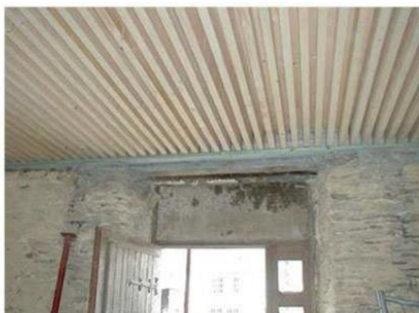
Figura 24 - Aspeto final da laje O'Portune sem o uso de materiais de acabamento (in www.cbs.cbt.com )
