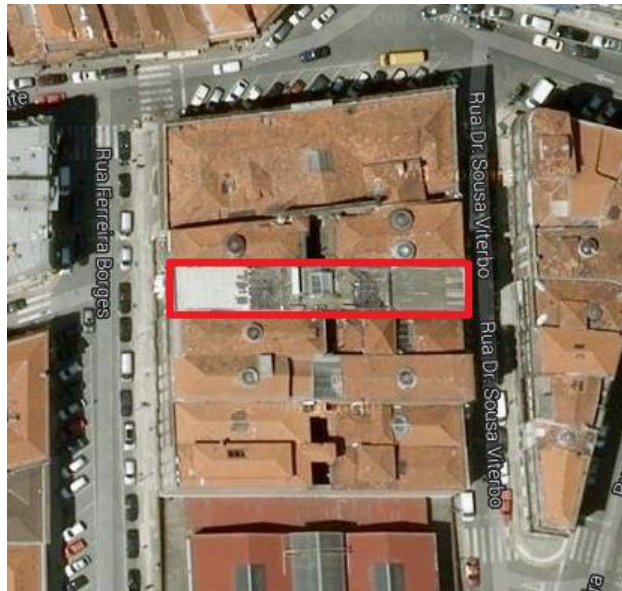
Figura 53 - Vista aérea do Edifício em estudo (in maps.com)
