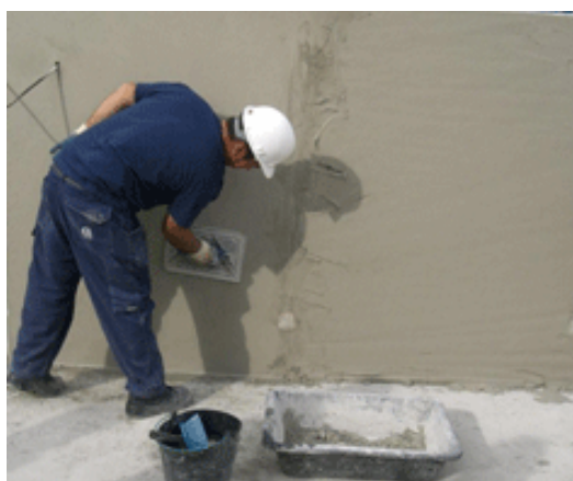
Figura 77 - Execução de reboco de parede divisória interior (in http://static.assimsefaz.com.br/imagens )
