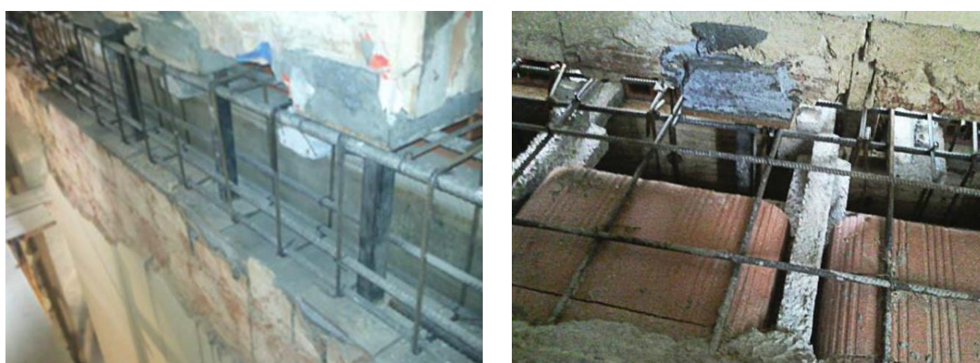
Figura 61 - Execução de uma viga de betão armado em parede de alvenaria de pedra e Laje aligeirada ligada à viga de betão armado (Santos, D., 2013. Dissertação de Mestrado)
