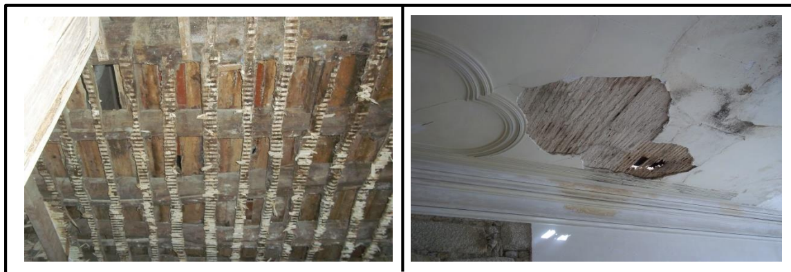
Figura 43 - Constituição e acabamento de tetos (Autoria própria)
