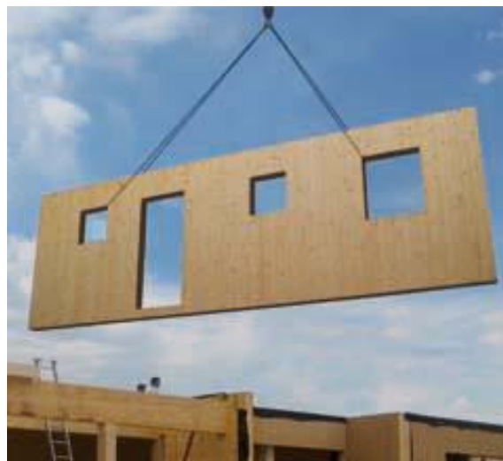
Figura 20 - Aplicação de painel CLT em obra (in www.storaenso.com)
