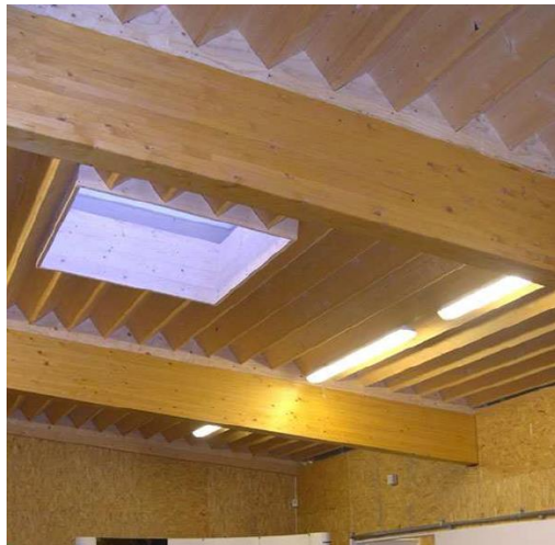
Figura 26 - Aplicação de um sistema Wenus num processo de reabilitação (in www.cbs.cbt.com )
