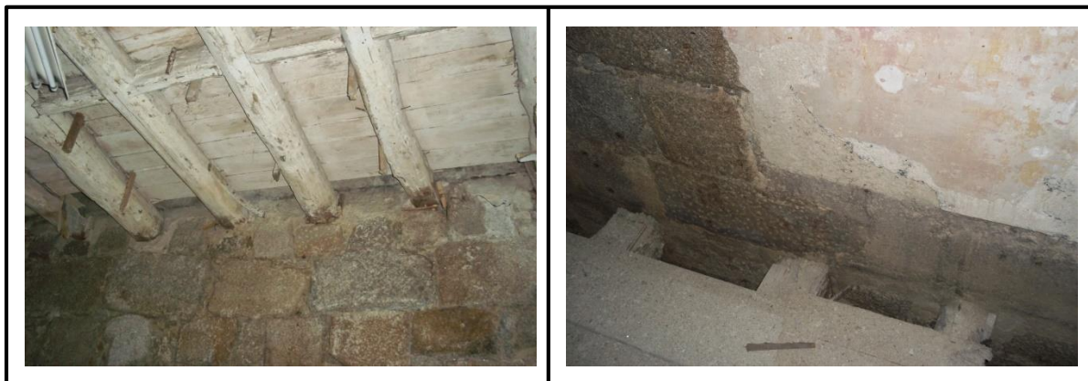
Figura 42 - Troncos de madeira apoiados nas paredes de meação com revestimento de soalho (Autoria própria)
