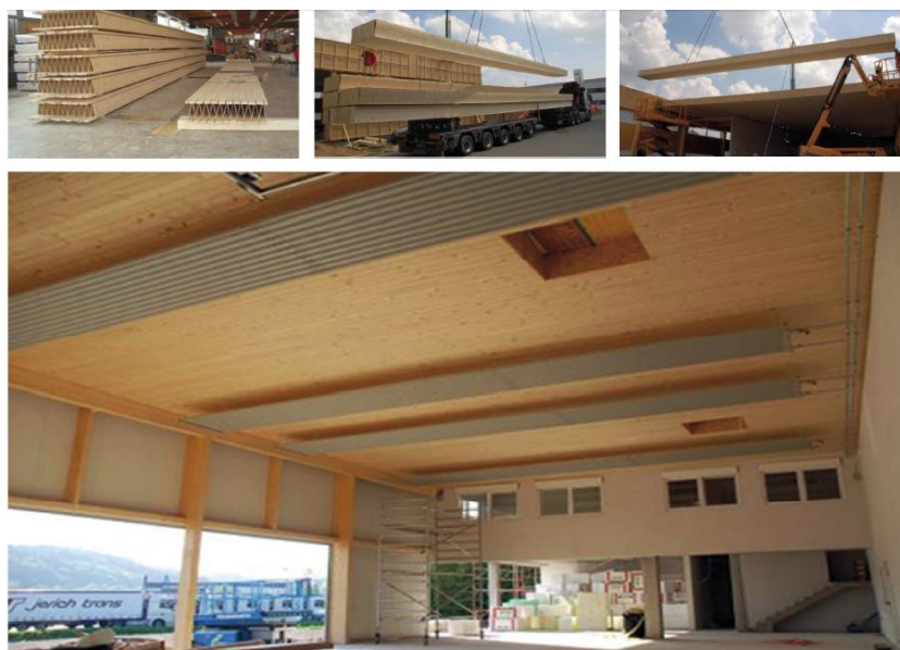
Figura 30 - Aplicação de um sistema Kielsteg (in www.kielsteg.at )
