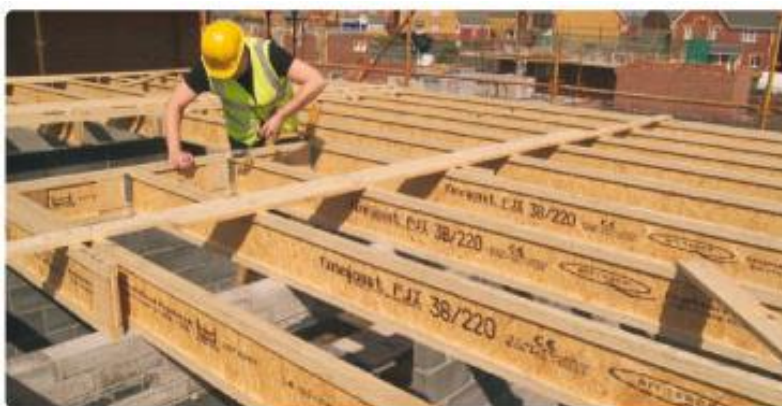
Figura 17 - Aplicação de Vigas I em obra (in www.jular.pt )
