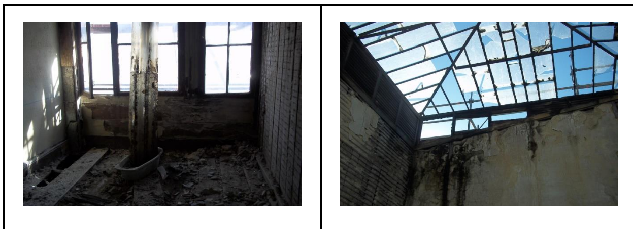
Figura 59 - Fotografias demonstrativas do estado atual de um compartimento da habitação e outra vista da claraboia (Autoria própria)
