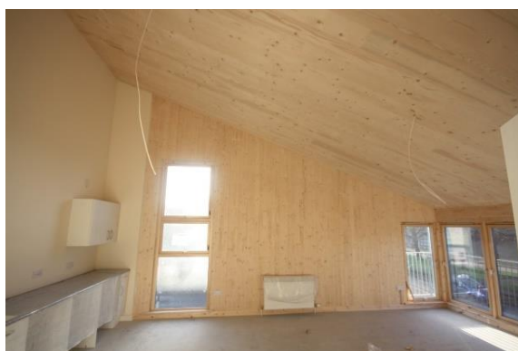
Figura 97 - O belo acabamento de uma cobertura de solução pré-fabricada do sistema “CLT” (in www.huntlycrescentaploch.co.uk )
