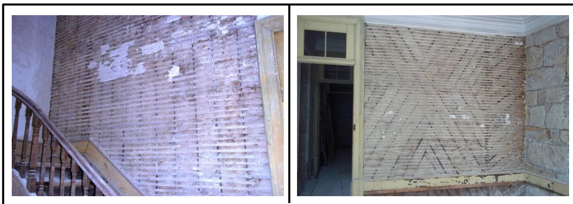
Figura 40 - Paredes em tabique (Autoria própria)
