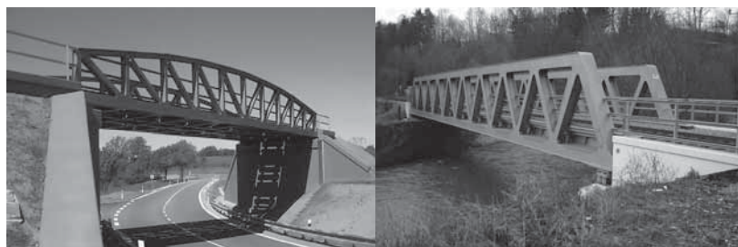
Fig 3 e 4. Exemplos de pontes com estruturas de treliça. Fonte: Railway bridges.
