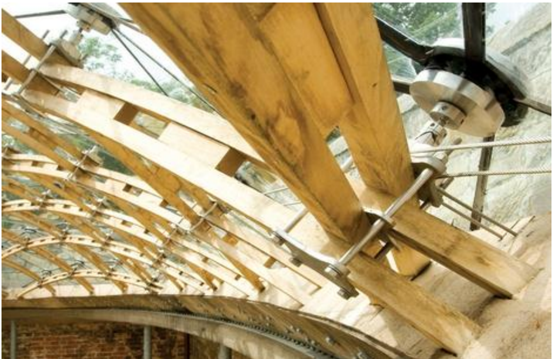
Figura 4- Ligações metálicas entrefaces.
