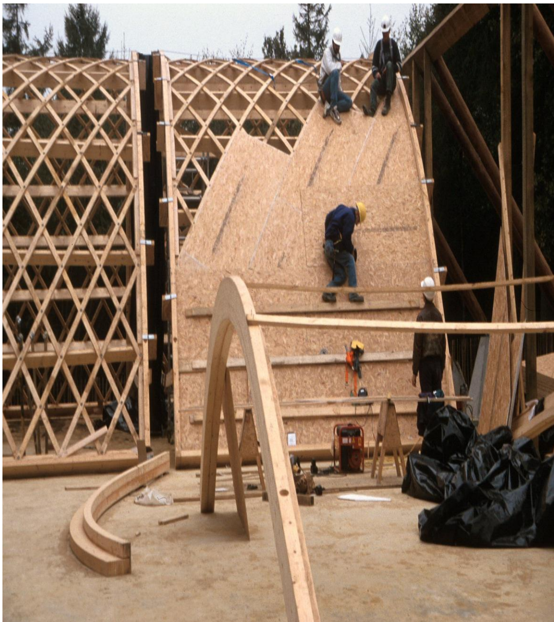
Figura 2- Estrutura de madeira, malhas estruturais.
