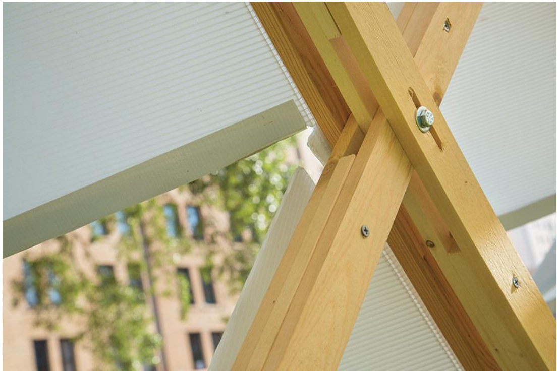
Figura 3- Ligações metálicas pinos metálico/ parafuso
