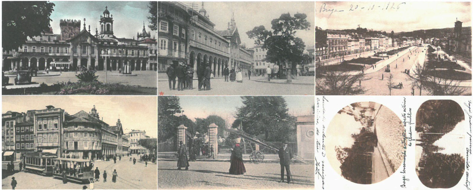
Figura 8 – Arcada/Praça da República/Avenida Central
