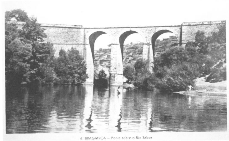
6. BRAGANÇA — Ponte sobre o Rio Sabar
