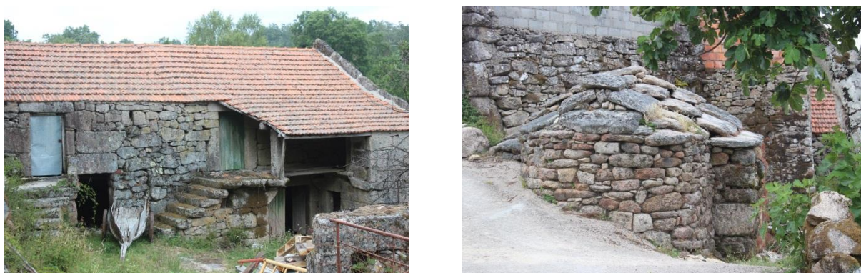
Figura 18 Inverneira de Alagoa. (Fonte própria, 2014)
