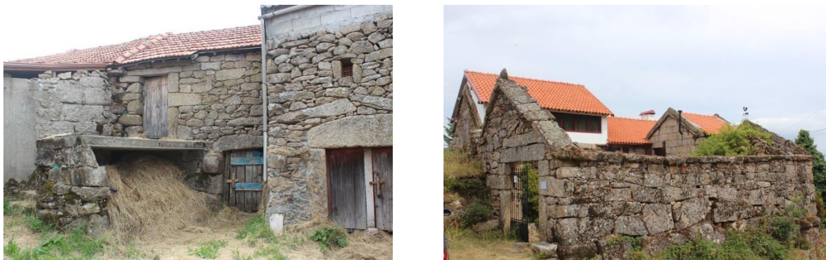
Figura 29 Inverneira da Entalada. (Fonte própria, 2014)
