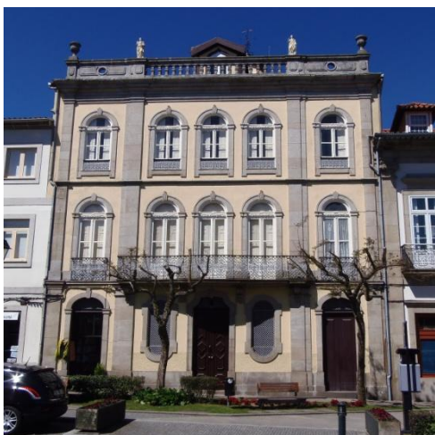
Fig. 15 – Casa Apalaçada Vertical de José Alves de Freitas (Foto de Autor)
