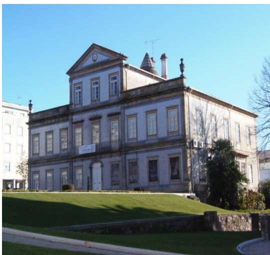
Fig. 11 - Palácio do Santo Novo/Casa da Cultura (Foto do Autor)
