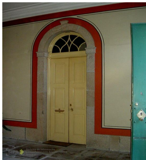
Fig. 24 - Interior, piso 1, átrio de entrada (SIPA)
