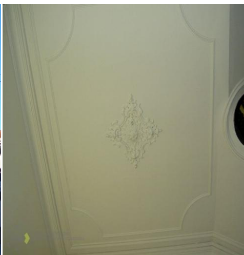
Fig. 3 – Piso 2, teto de estuque no corredor (SIPA)
