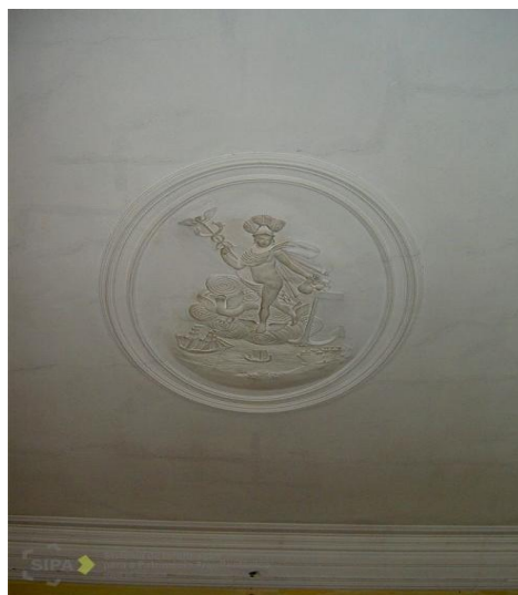
Fig. 13 - Piso 2, teto de estuque no corredor (SIPA)
