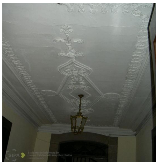
Fig. 37 – Piso 1, teto do átrio da entrada (SIPA)
