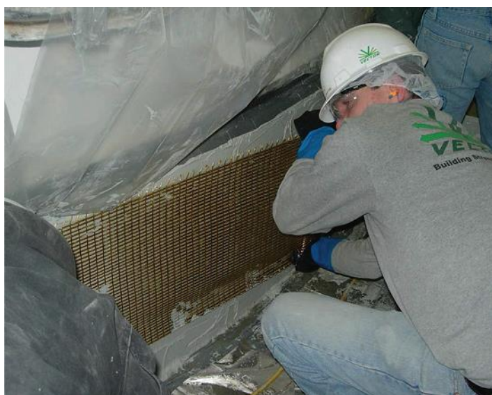
Figura 18 - Instalação do sistema de reforço FRCM
