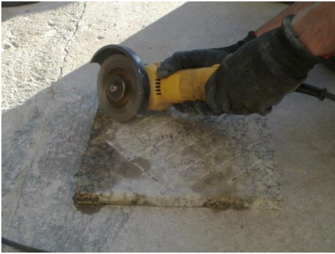
Figura 38 - Abertura de juntas na pedra de granito para melhor aderência.
