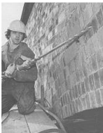
Figura 11 - Técnica de consolidação através de pregagens.
