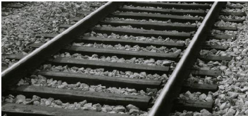
*Figura 2.7– Via-ferroviária com travessas em madeira (CP s.d.)*
