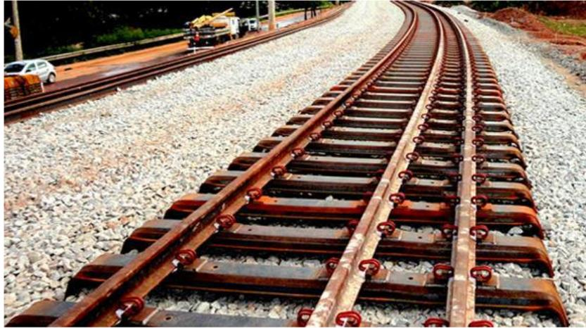
*Figura 2.8 – Via balastrada com travessas metálicas (Hidremec s.d.)*
