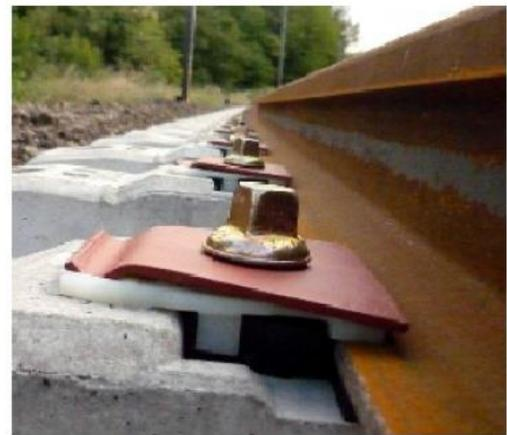
Figura 2.6 – Elementos de fixação elásticos (Fernandes 2011)
