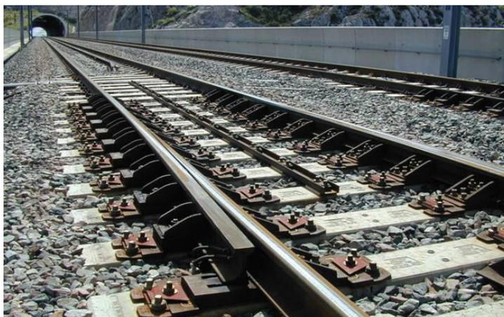
Figura 3.4 – Aparelho de dilatação da via (Schmitt 2007)
