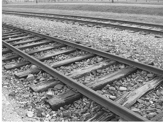
*Figura 3.6 – Travessas em madeira degradadas*
