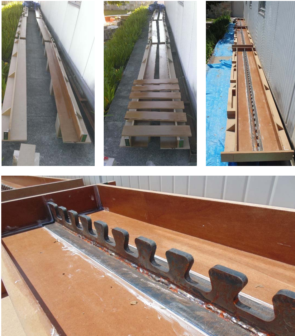
Figura 4.7: Cofragem da viga mista
