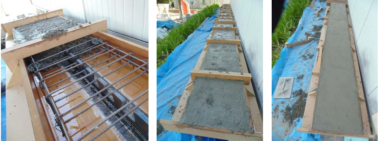
Figura 4.10: Betonagem da viga
