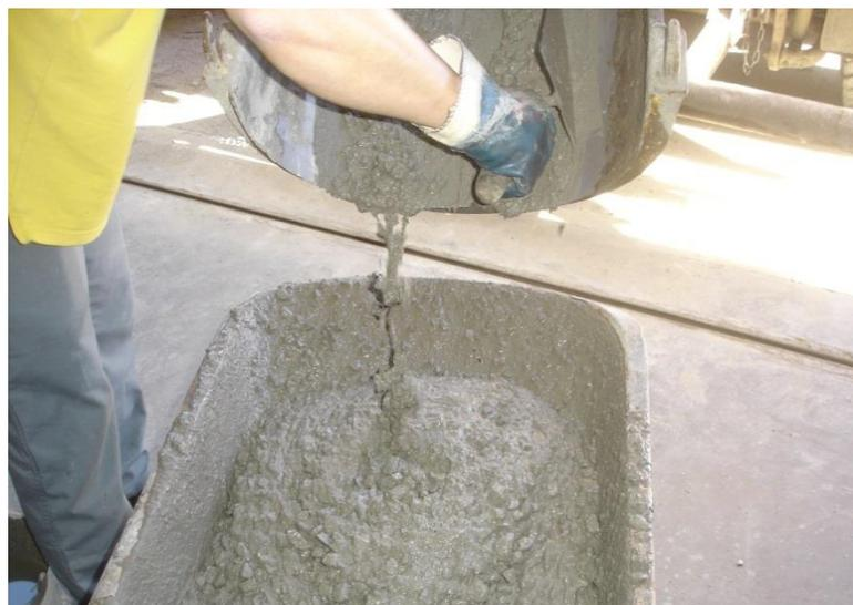
Figura 29 – Descarga do betão produzido para posterior betonagem dos moldes
