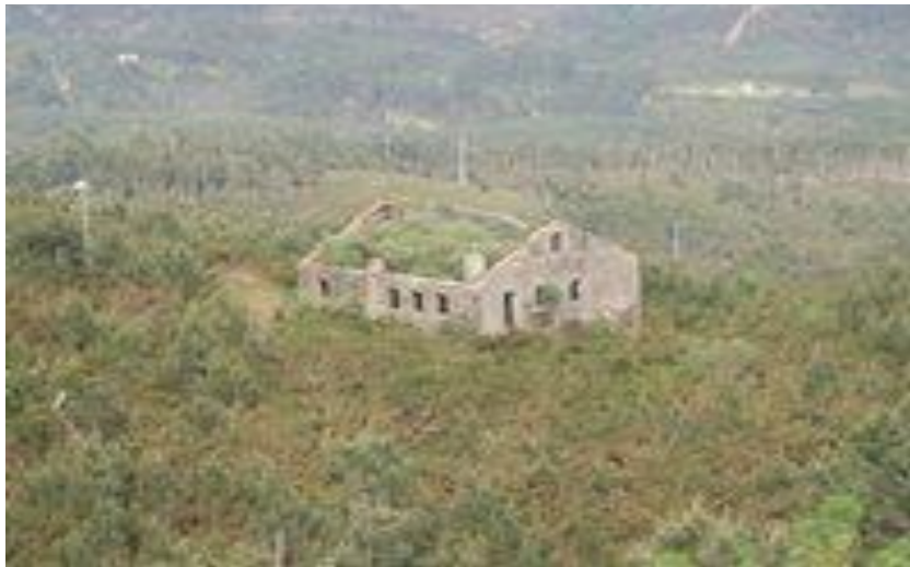
Figura 58 - Casa da Direção – fotografia atual
