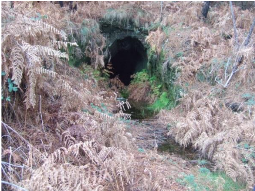
Figura 22 – Galeria da concessão mineira do Cavalinho – fotografia atual
