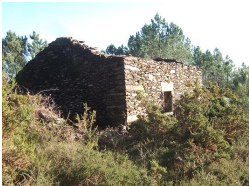
Figura 25 – Casa de xisto da antiga lavaria – fotografia atual.
