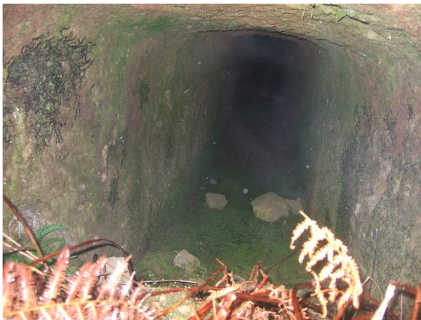
Figura 47 – Galeria da Mina de Estorãos
