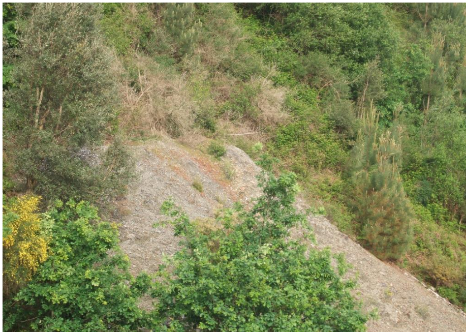
Figura 53 – Escombrela da Mina do Fulão
