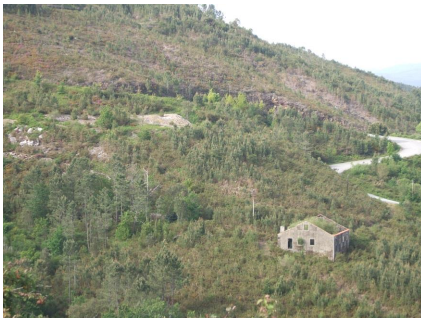
Figura 50 – ‘Casa da Direção’ e escombrela da Mina de Fulão
