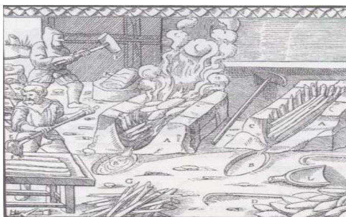
Fig.1 - Forno português - fusão estanho de Georgius Agrícola no ano de 1556 retirada do artigo de Ferreirinha, J. (1995) publicado na revista nº 200 da APF
