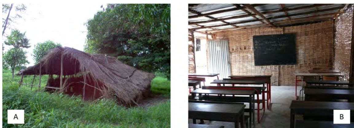
Figura 6.4 - Escolas de construção precária: escola de palha e colmo (A) e escola com paredes de quirintim mas com teto de chapa de zinco e chão de cimento (B).
