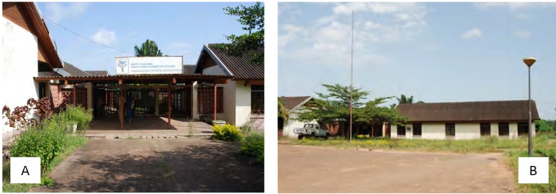
Figura 6.5 - Instalações do INDE onde decorreu a formação "Kit Energia, Ambiente e Sustentabilidade": entrada principal (A) e vista exterior (B)
