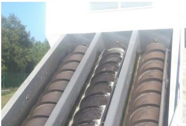
Figura 4. Elevação inicial (parafusos de Arquimedes) ETAR de Serzedo.
