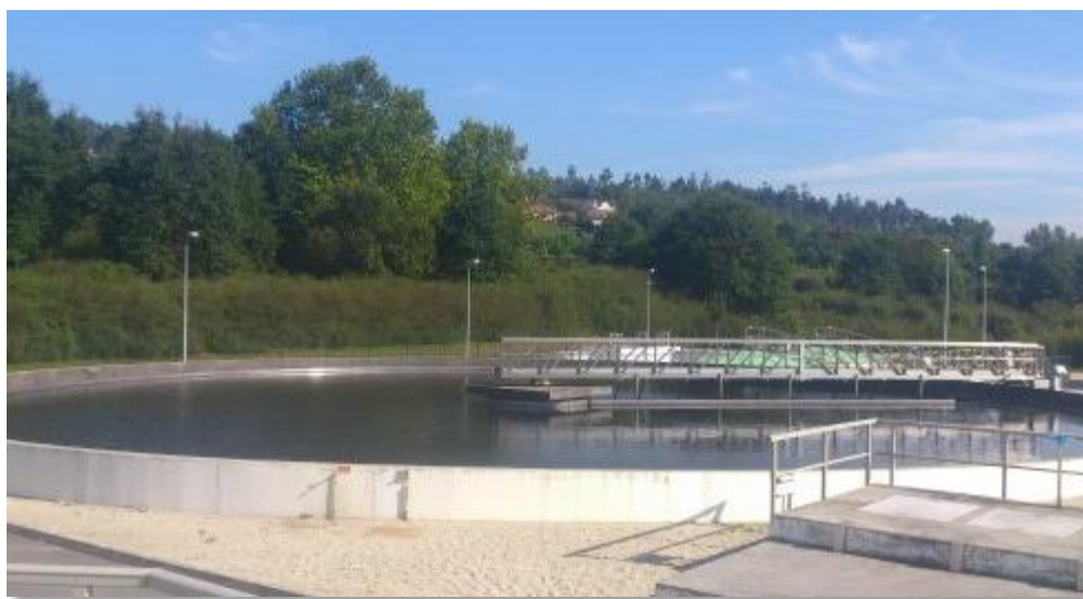
Figura 6. Decantador secundário da ETAR de Serzedo.
