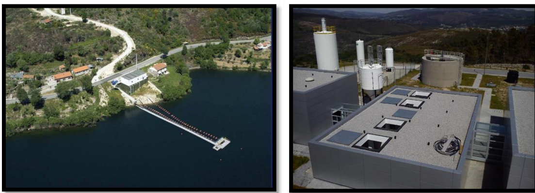
Figura 23 e Figura 24 - Da esquerda para a direita: zona de captação do subsistema do Rabagão, na barragem da Venda Nova. Vista superior ETA do Rabagão.
