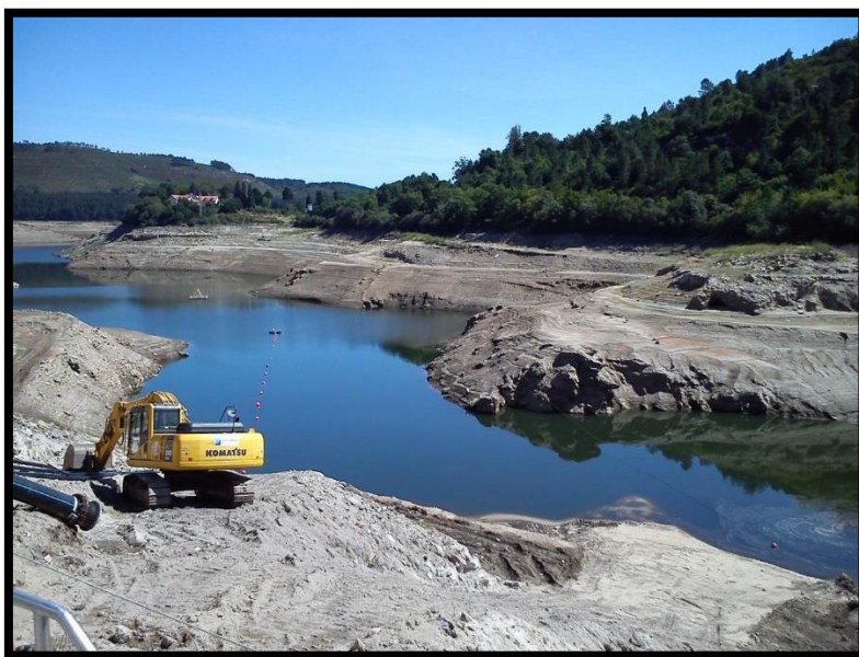
Figura 26 - Local provisório da captação de água. Vista do impacto do abaixamento do nível da albufeira da Venda Nova por parte da EDP.
