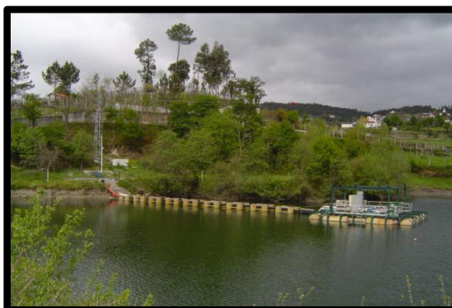
Figura 5 - Zona de captação da ETA das Andorinhas.
