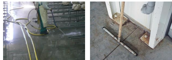
Figura 30: Limpeza do chão.
