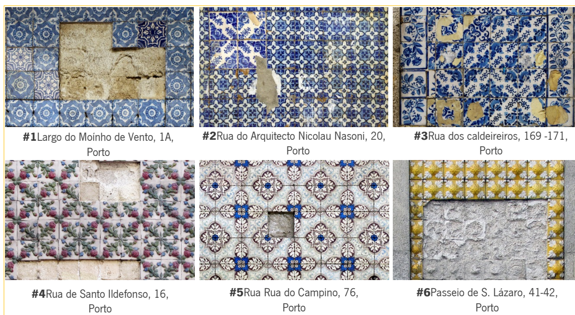
Figura 64 - 1#Porto, Registo fotográfico das fachadas. fotos: Teresa Abreu, 2014
