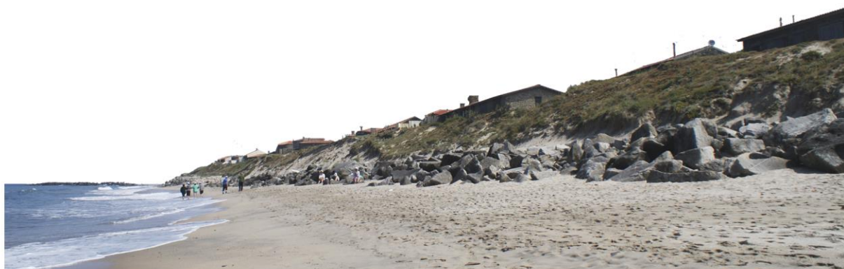
Figura 90. Fotografia da obra longitudinal aderente e do esporão, Pedrinhas
