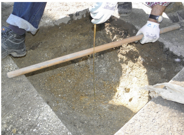
Figura 25 - Medição das espessuras por abertura de poço
