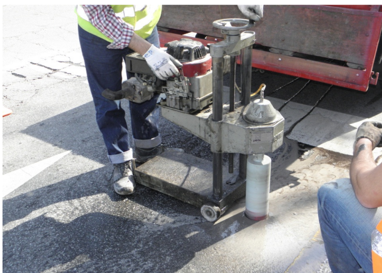
Figura 26 - Sondagens à rotação (carotagem)
