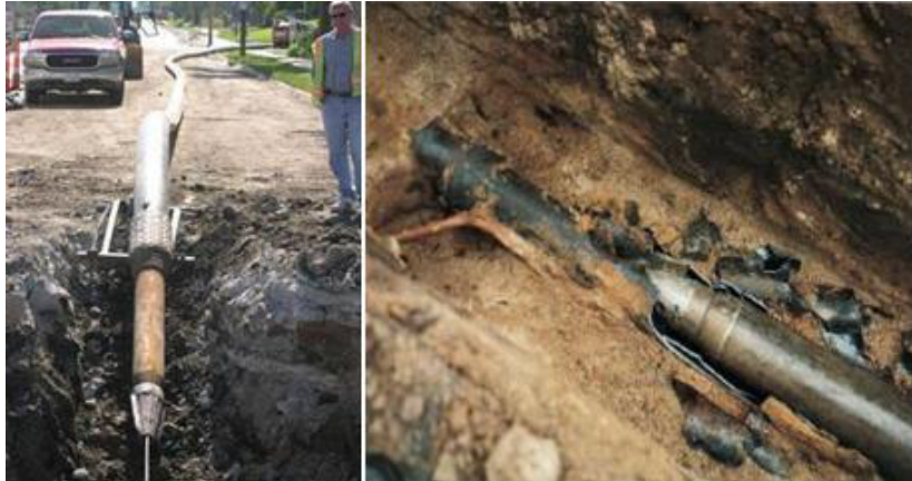
Figura 56 - Re-entubamento por destruição - pormenor de funcionamento
