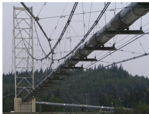
Figura 4 - Exemplo de transporte tubular aéreo no Alaska
