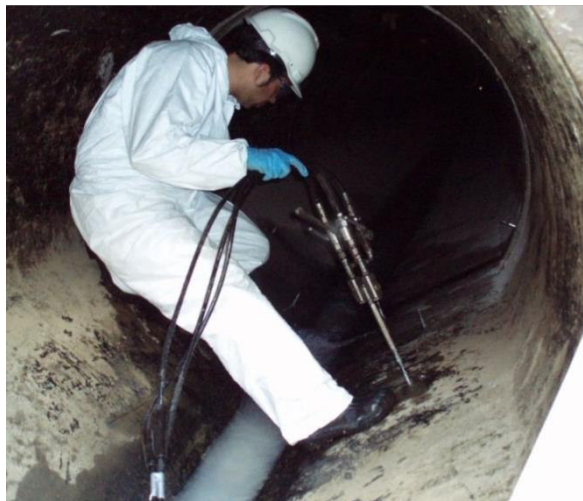
Figura 47 - Aplicação da resina em conduta de grandes dimensões
