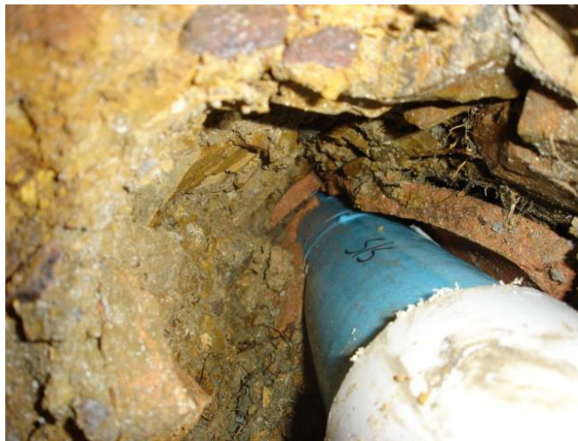
Figura 54 - Re-entubamento simples
