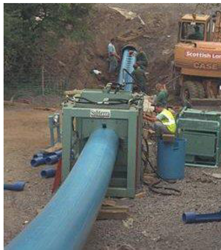
Figura 59 - Inserção de conduta nova
