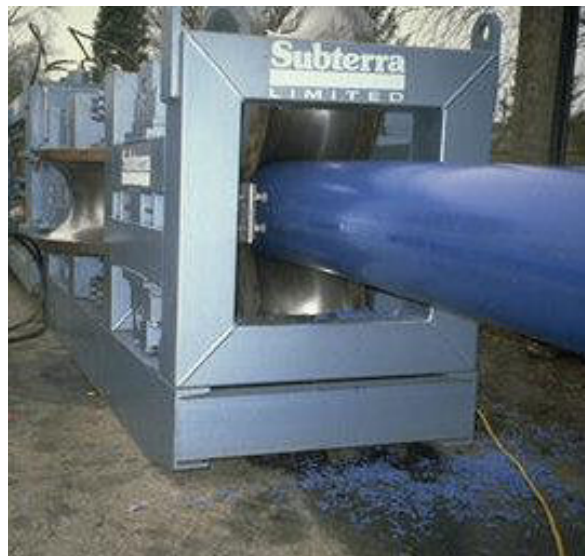
Figura 58- Compressão diametral do tubo
