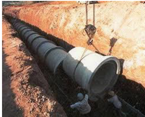
Figura 11 - Instalação de conduta para transporte tubular
