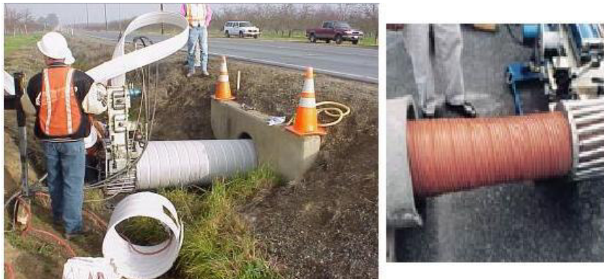
Figura 62 - Revestimento por tira em espiral
