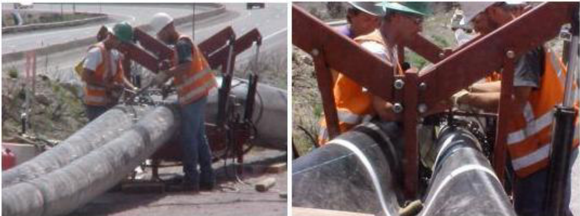
Figura 61 - Re-entubamento por parede dobrada " in situ "
