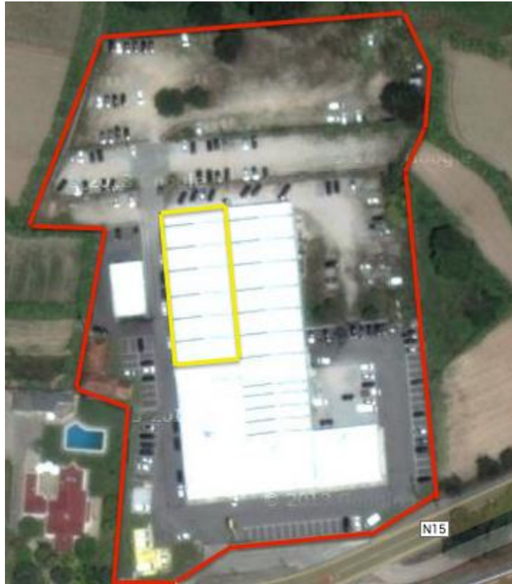
Figura 2 - Instalações de Paredes (Grupo JAP – Paredes, 2013)
