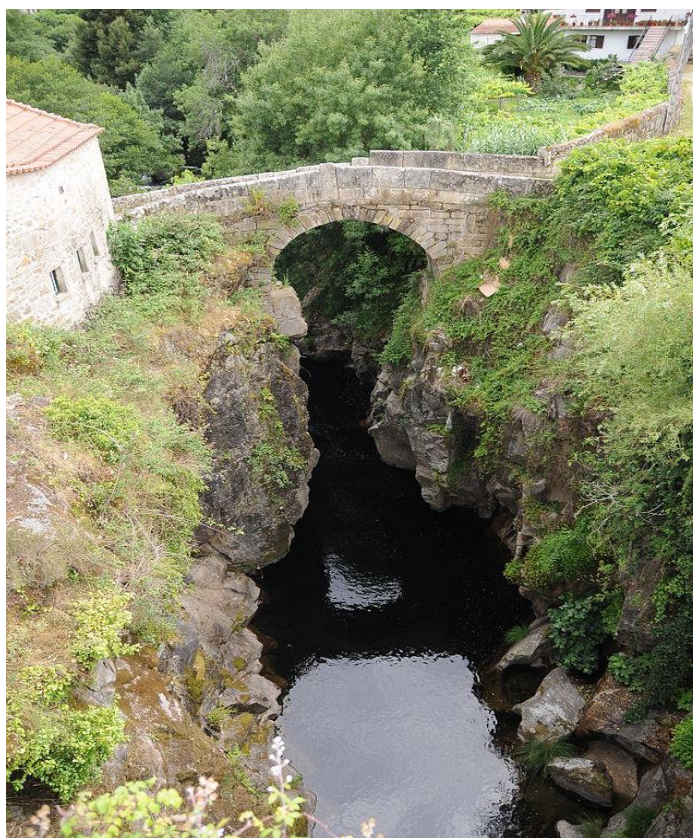
Ilustração 9 - Ponte sobre o rio Mouro. Fonte: Wikipédia 267
