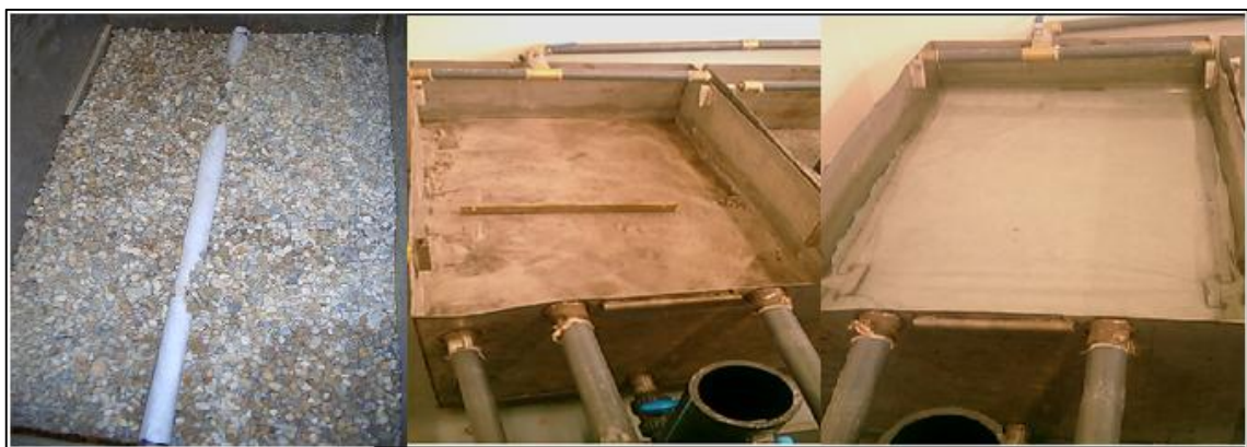
Figura 4.1 - Tanque de Filtração Lenta: Esquerda e centro - durante montagem de filtro; Direita - em funcionamento.
