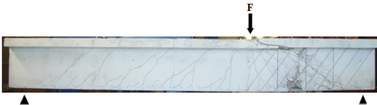
b) Viga 3S-9LI-M
