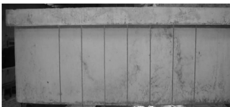
c) Entalhes efetuados no betão de recobrimento da face lateral da viga
