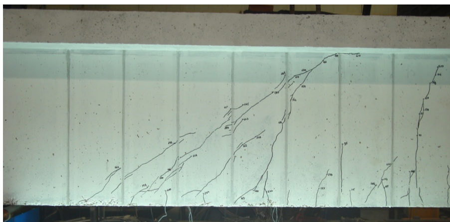
Figura 3.29 - Padrão de fendilhação da viga 3S-7LV-C antes do carregamento cíclico.
