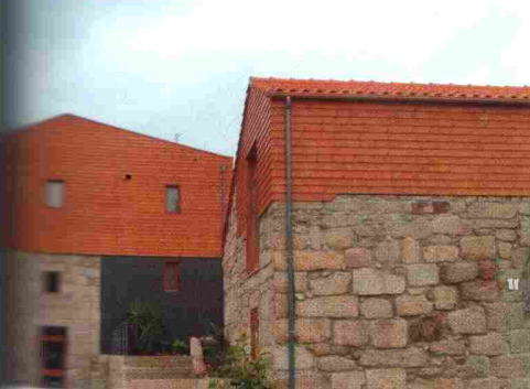
Figura 2 – Quinta do Outeiro em Amarante, aplicação de madeira termicamente modificada como revestimento exterior de fachada. Fonte: www.banema.pt
