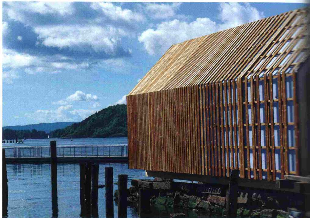
Figura 1 – Madeira modificada por Kebony aplicada em deque e fachada, Boat house em Oslo, Noruega. Fonte: www.kebony.com
