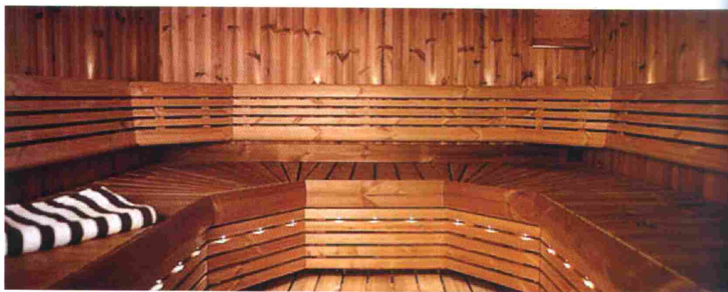
Figura 3 – Madeira termicamente modificada aplicada como interior de uma sauna. Fonte: www.lunawood.fi
