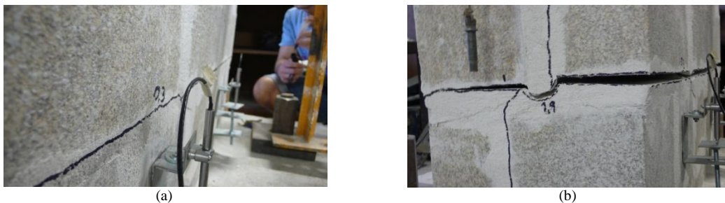
Figura 109 – Fissura da parede URW.2: (a) aparecimento da fissura aos 0,3 kN; (b) fissura muito aberta
