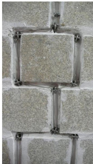
Figura 122 – Reforço de uma das duas restantes paredes
