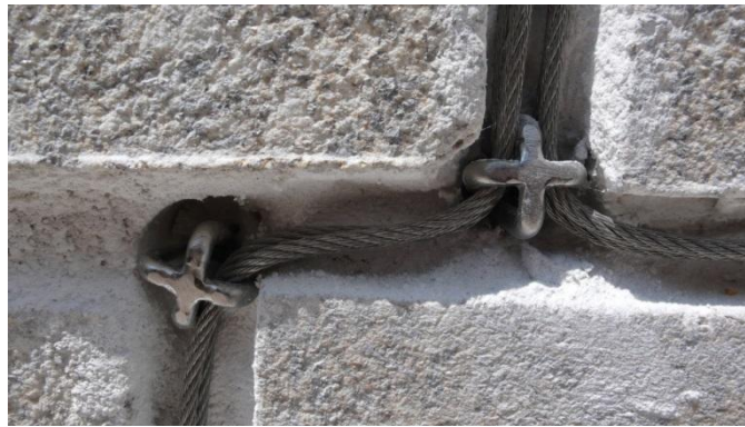
Figura 95 – Passagem dos cabos pelas heli-agulhas
