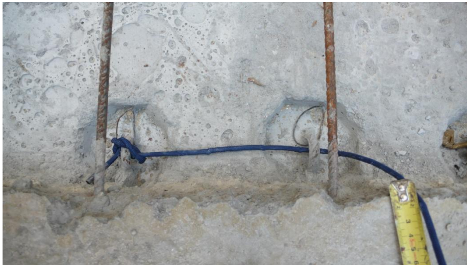
Figura 66 – Amarração dos cordões através de nós
