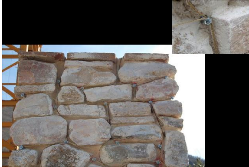
Figura 34 – Sistema de reforço criado por Antonio Borri com cabos de aço a percorrer as juntas
