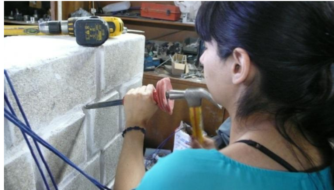
Figura 92 – “Limpeza” das juntas
