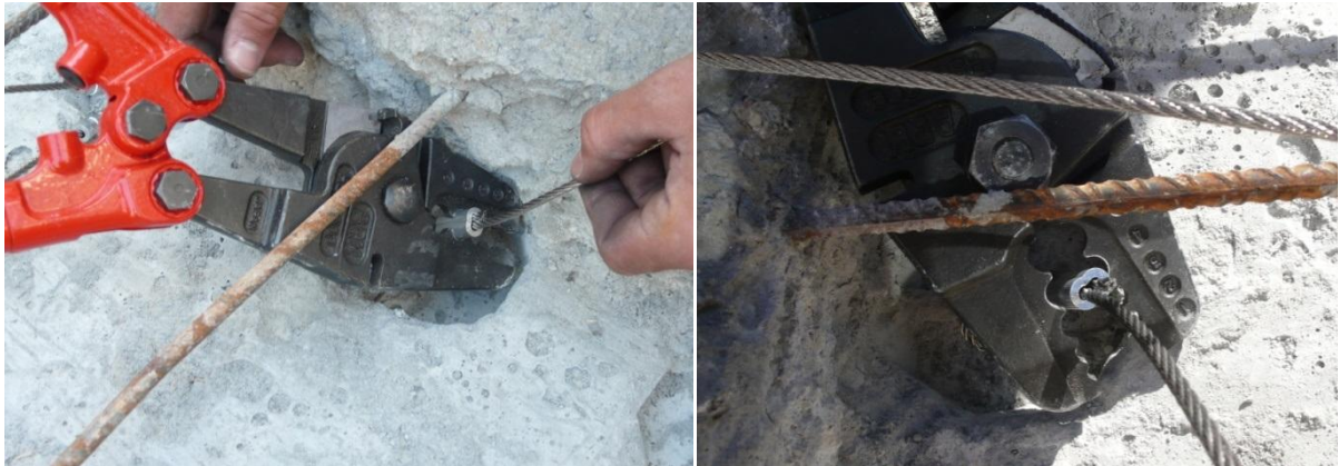
Figura 65 – Amarração dos cabos de aço com recurso a estropos
