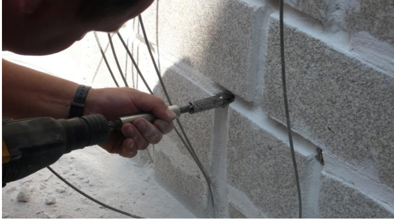
Figura 94 – Sistema desenvolvido para facilitar a penetração das heli-agulhas
