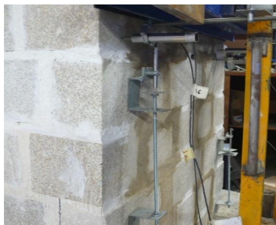
Figura 118 – Nova posição dos transdutores LVDT
