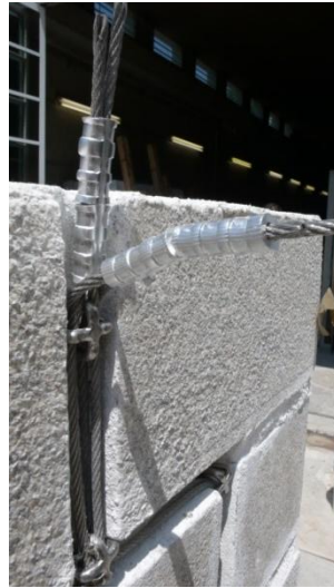
Figura 96 – Fixação dos cabos no topo da parede
