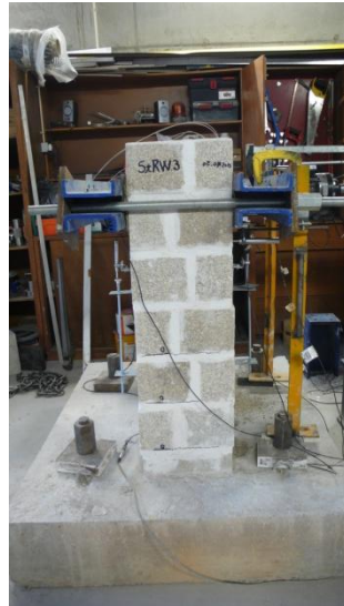
Figura 128 – Fissuras existentes na parede StRW.3
