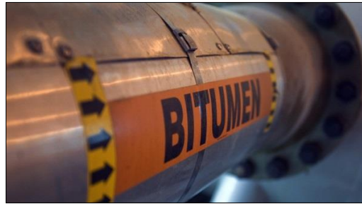
Figura 3.9 – Tubagem por onde escoo o betume nas centrais betuminosas
