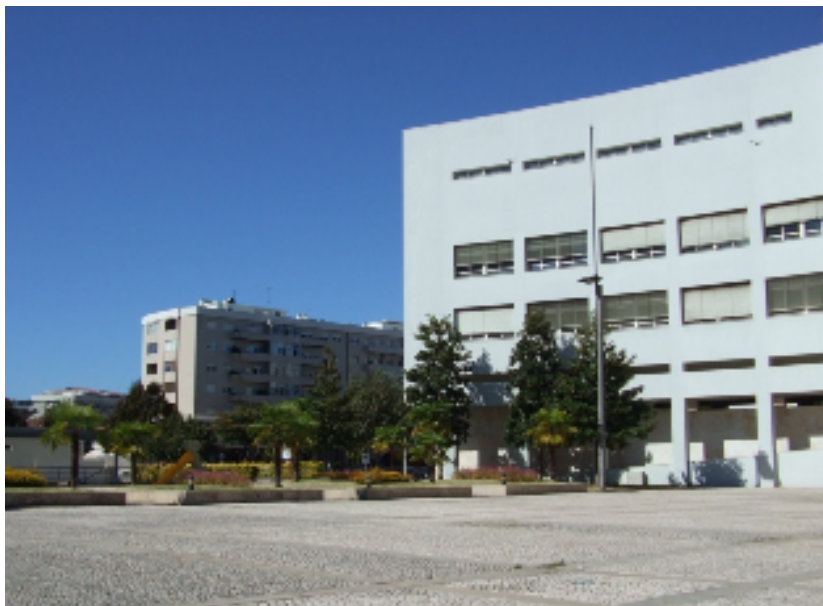
Figura 25- Pavimento existente na Praça da Justiça
