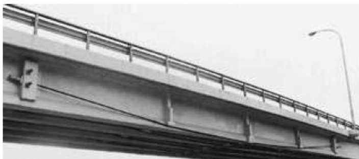
Figura 2.3 - Reforço de um viaduto aplicando pré-esforço exterior (Rodrigues, 2005).
