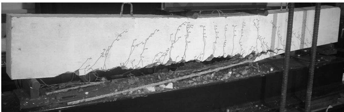
Figura 3.30 - Pormenor do modo de rotura da viga S3-PC1 (destacamento do laminado de CFRP).
