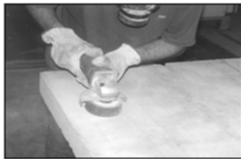
a) Preparação da superfície (manta)
