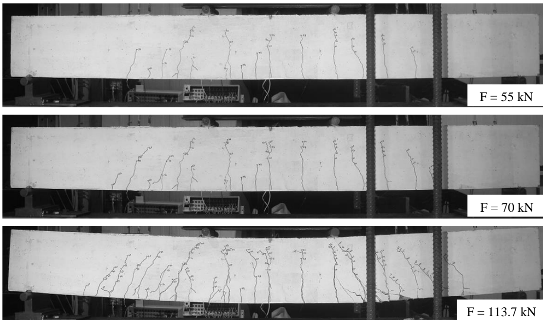
Figura 3.25 - Sequência do ensaio à rotura da viga S2-PC2.
