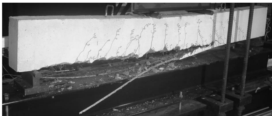
Figura 3.33 - Pormenor do modo de rotura da viga S3-PC3 (destacamento do laminado de CFRP).
