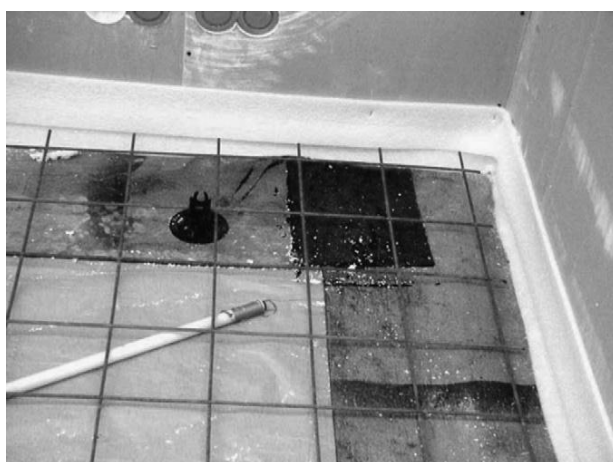
Figura 23: Feltro de betume instalado na junta da parede de fundação e laje de pavimento antes da colocação do pavimento (Arvela et al., 2005).
