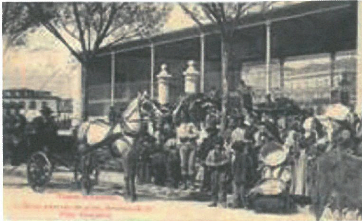
Figura 13: Novo Mercado do Peixe, denominado Pena Gonçalves. Ed. Bazar Couto Viana. Circ. 1910.
