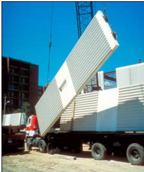
Figura 22 - Painéis sandwich depositados em obra
