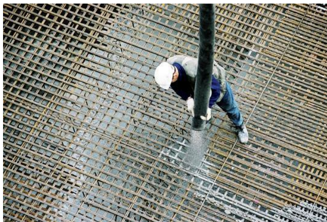
Figura 28 - Aplicação de betão auto-compactável
