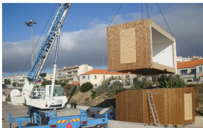
Figura 18 – Processo de montagem TreeHouse (TreeHouse, 2012)
