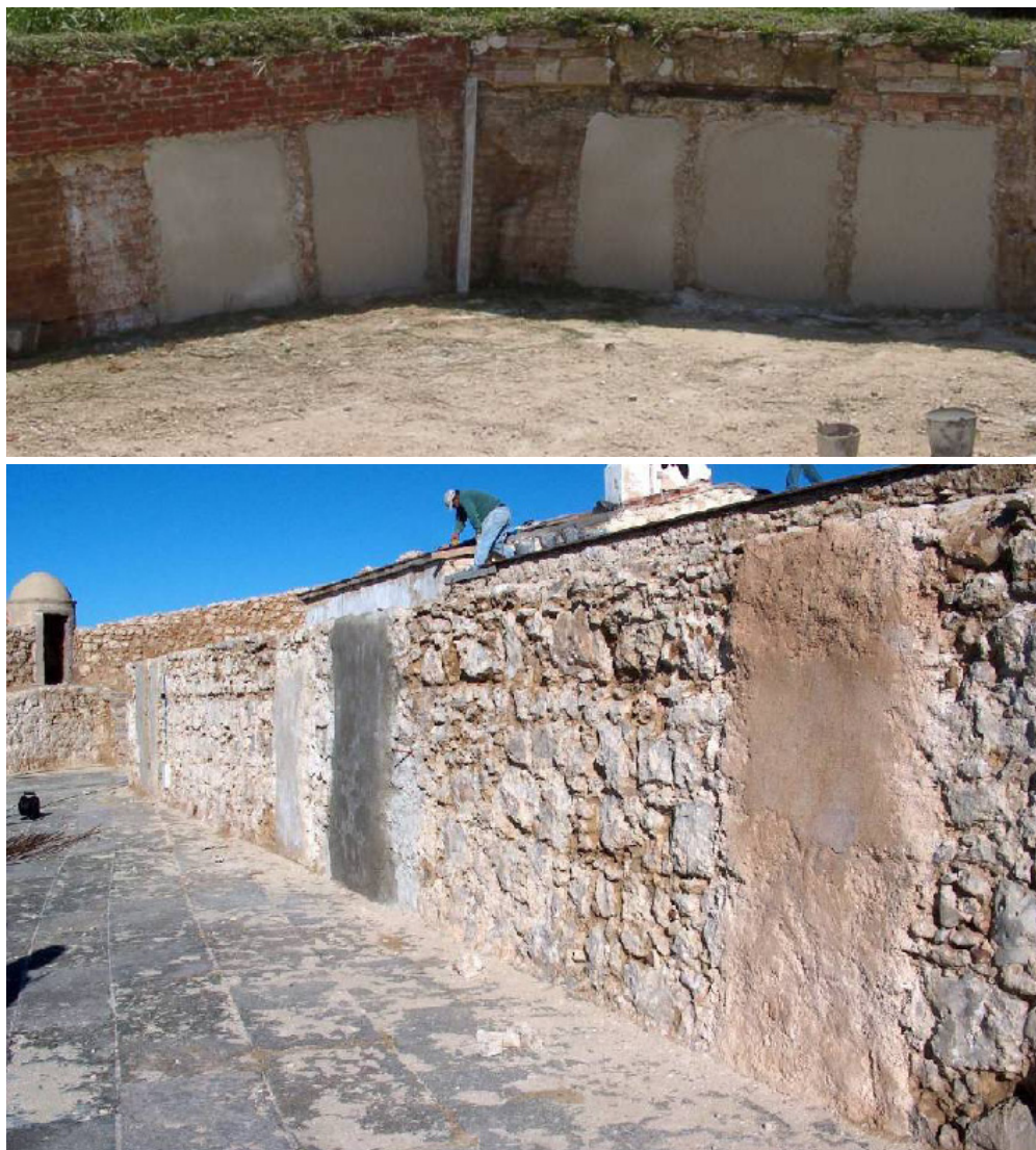
Figura 6.13: Realização de painéis experimentais para avaliar o comportamento das argamassas de revestimento em suportes de alvenaria de tijolo maciço (em cima) ou em suportes finais de alvenaria de pedra (Veiga, 2003)
