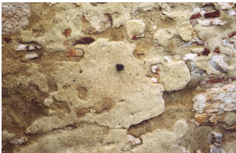
Figura 6.10: Argamassa recente de cal apagada com gordura: perda de coesão e erosão (Veiga, 2003)
