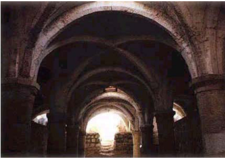
Figura 6.9: Ruínas da cisterna da fortaleza de Ormuz (Sá, 2005)
