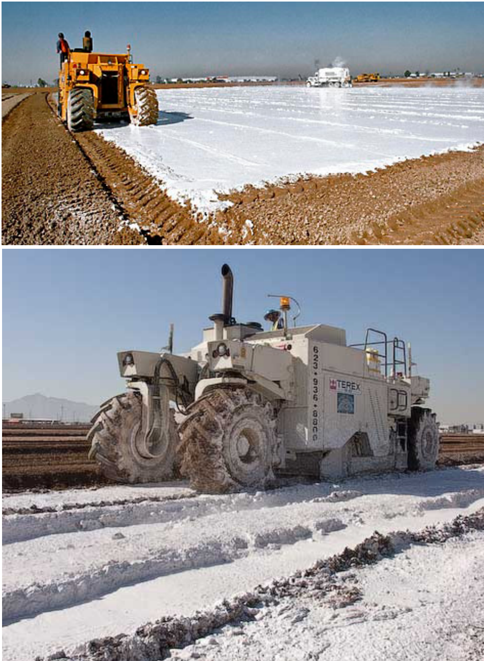
Figura 4.5: Estabilização de solo com cal
