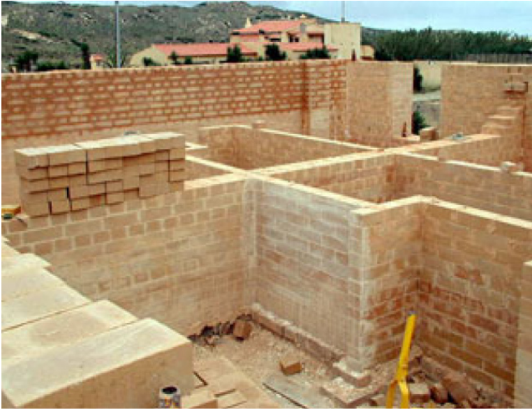
Figura 4.11: Em cima construção de alvenarias com recurso a BTC-Alentejo; em baixo várias unidades de BTC
