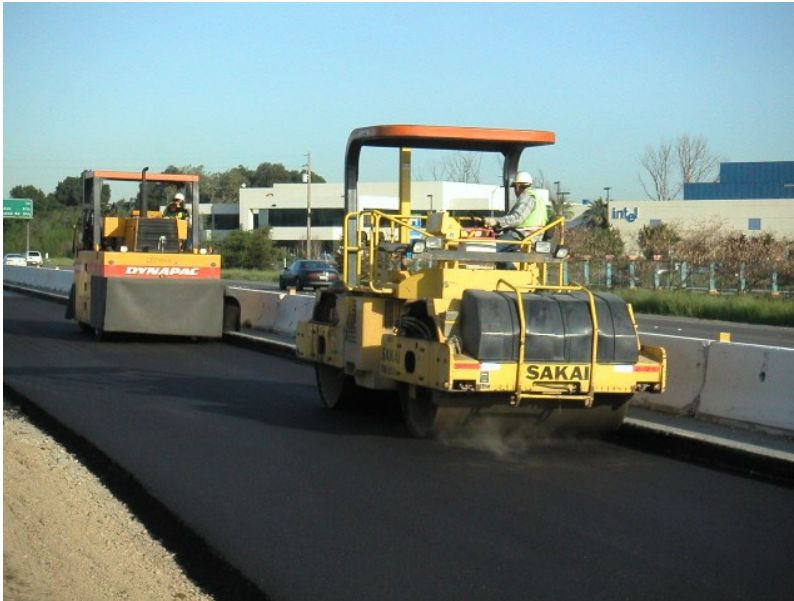
Figura 4.14: Execução de camada de revestimento betuminoso
