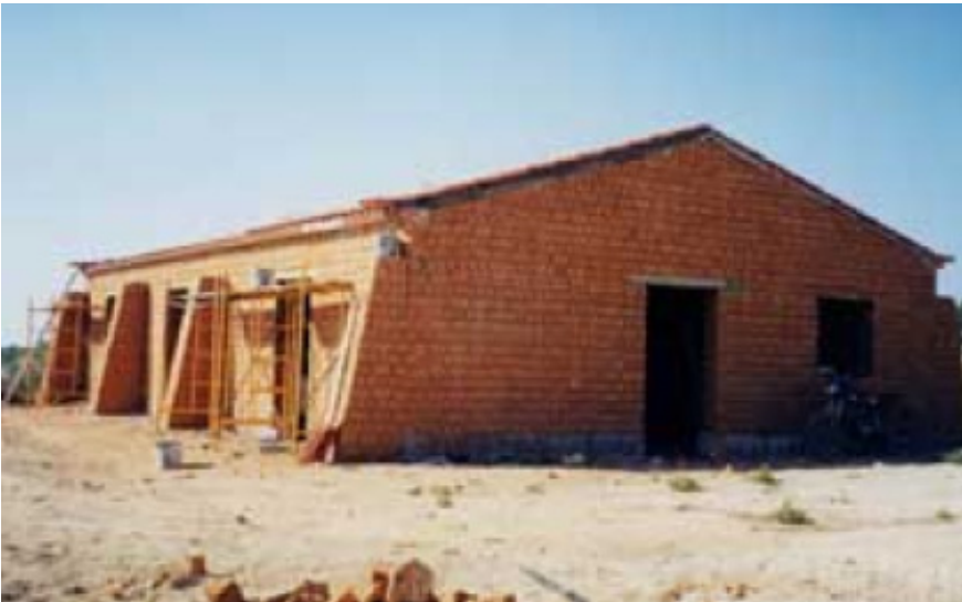
Figura 4.9: Edifício com paredes em blocos de adobe construído no Algarve (Mateus, 2004)
