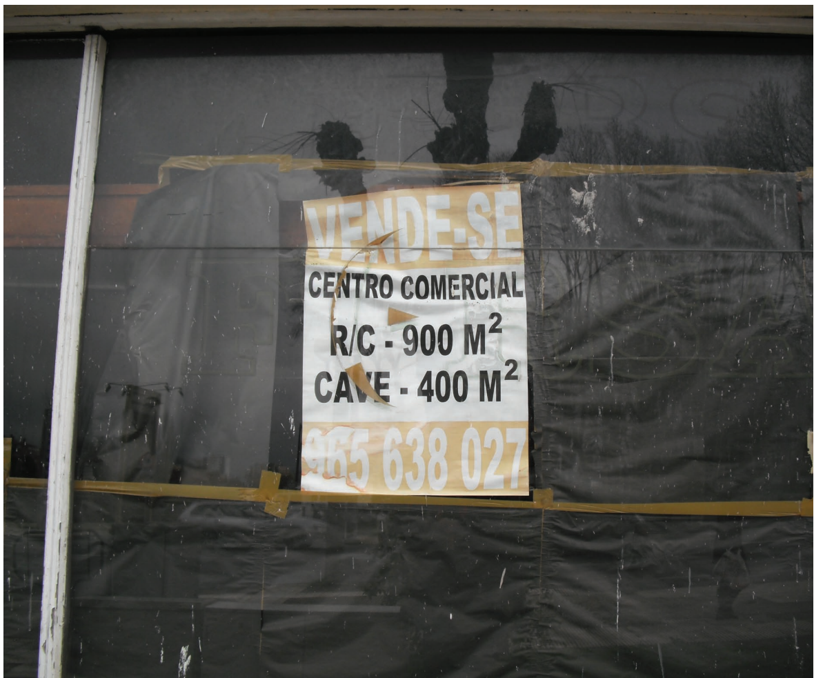
Fachada do Centro Comercial Este (Fevereiro de 2013)
