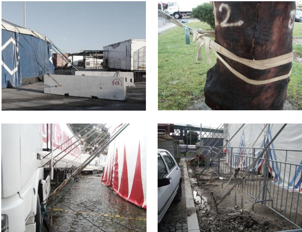
Fig.25 Diferentes tipos de alicerce do chapiteau
