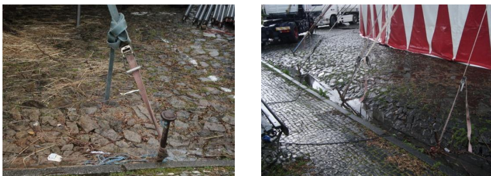
Fig.26 Tipo de sustentação do chapiteau através de estacas cravadas no chão
