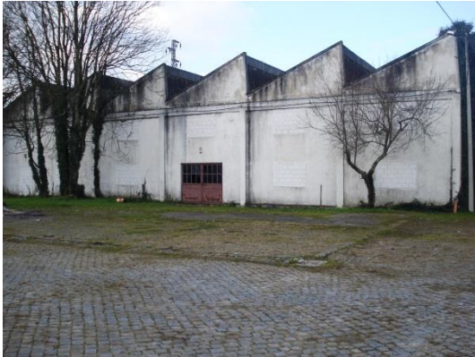
Imagem 59: Chão de cubos de granito existente nas fábricas
