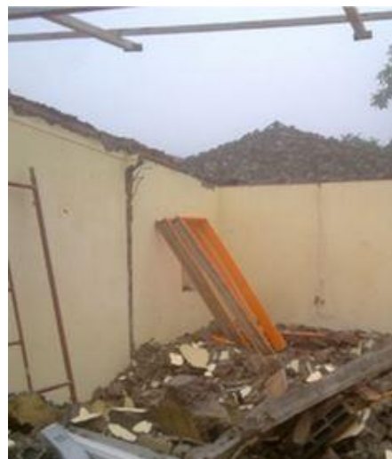
Imagem 2: Demolição antes da reconstrução
