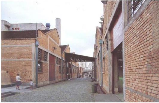
Imagem 36: Rua interna hoje
