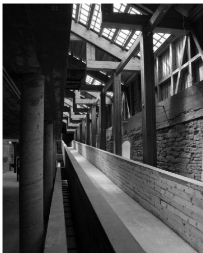
Imagem 54: Passadiço de betão armado que permite a comunicação entre os espaços
