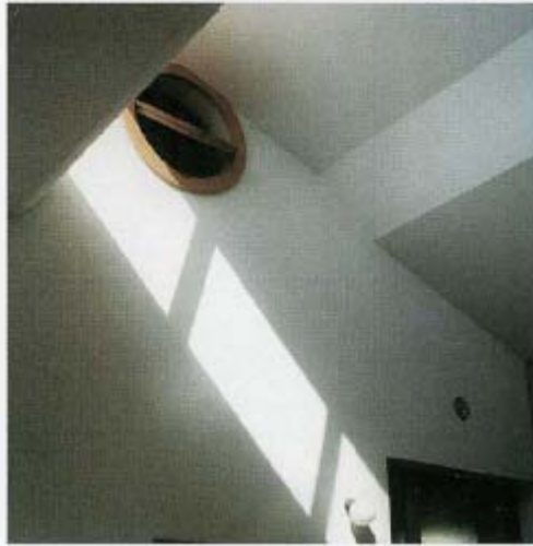
Figura 2.14 – Óculo circular destinado à ventilação da sala [3]
