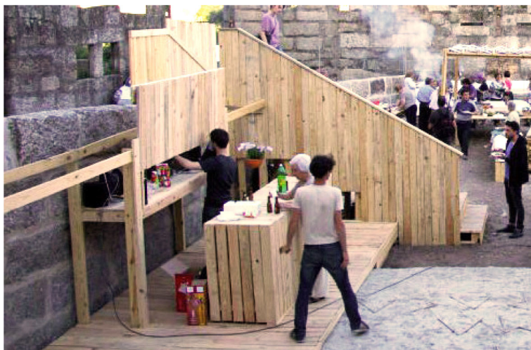
27.2 Pormenor em que já se pode ver a bancada do bar destacada da parede.
