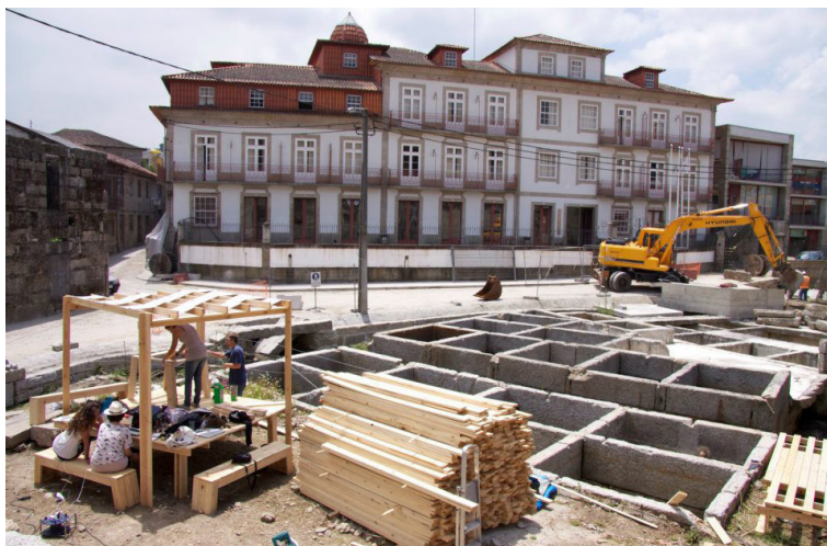
22.2 Momento ainda inicial da construção da Praça em que a mesa e a respetiva cobertura já se encontram finalizadas.
