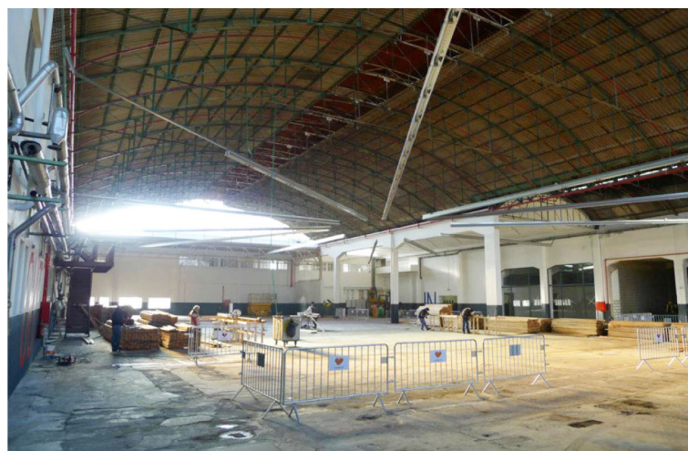
1.4 Preparação da ala central da Fábrica para o início da construção.
