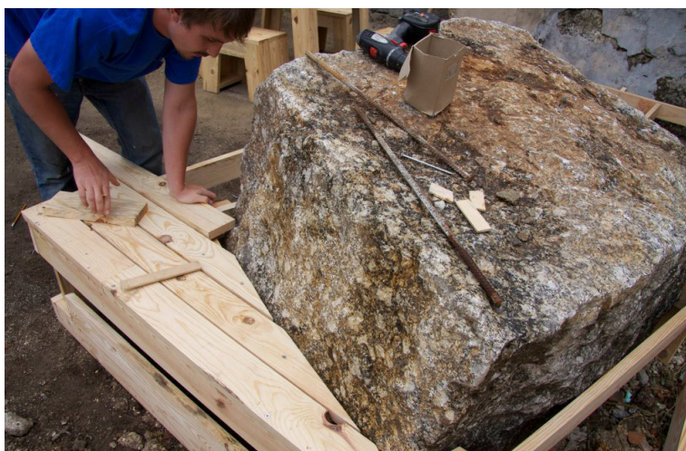
26.3 Pormenor de construção de uma das estruturas em que o palco envolve uma pedra que faz parte do terreno.
