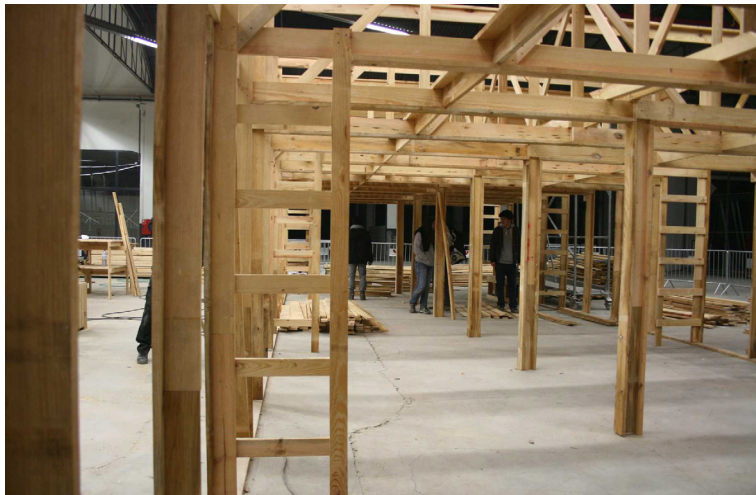
8.2 Imagem interior do espaço com o esqueleto da estrutura já completo.
