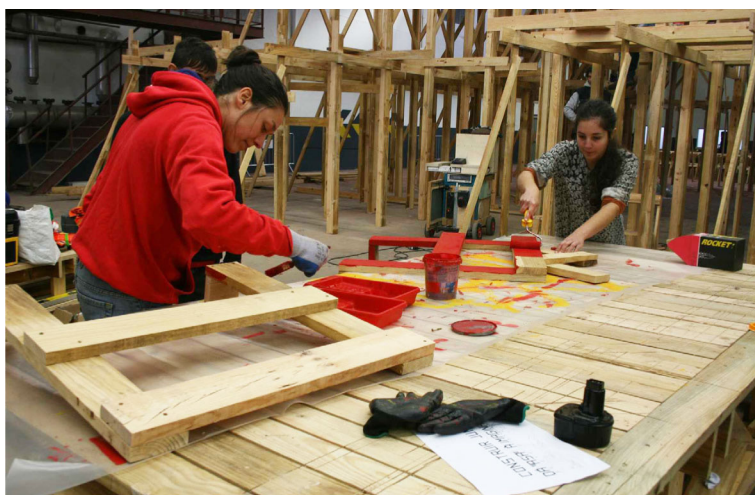
12.3 Momento de preparação das letras "dá asa à imaginação" que depois foram colocadas na estrutura.
