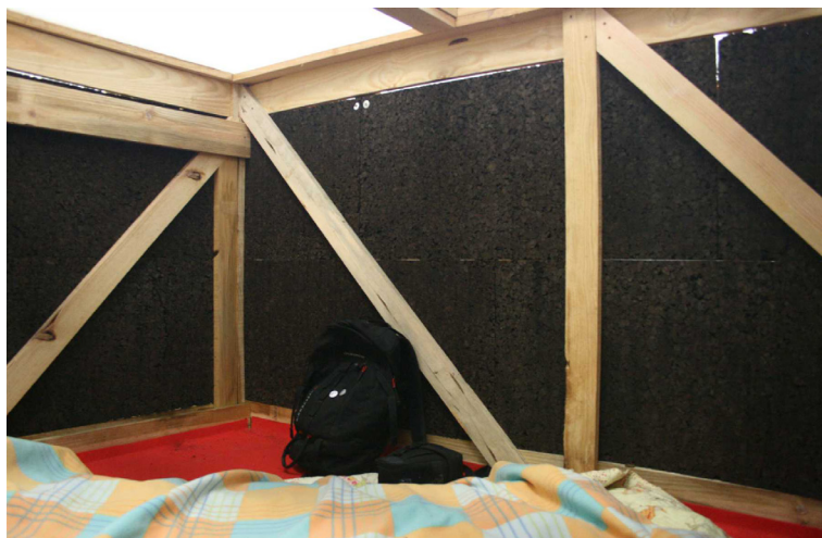
7.6 Vista interior de um dos quartos ocupado durante o workshop .
