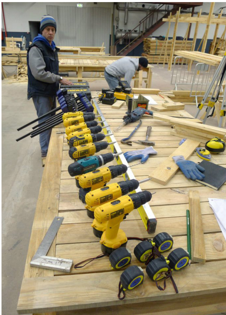
2.2 Imagem de uma das mesas de trabalho onde se podem ver as ferramentas base a utilizar na construção.
