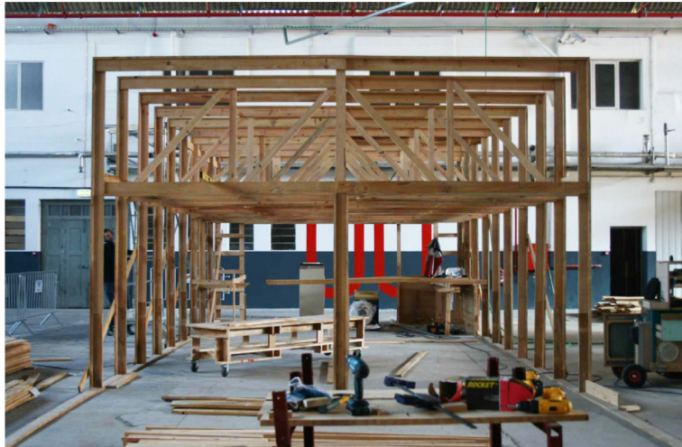
8.1 Imagem da junção dos pórticos da área de infraestruturas onde já se começa a identificar o espaço da sala de estar.
