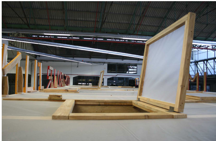
7.5 Pormenor das janelas dos quartos no teto da estrutura.
