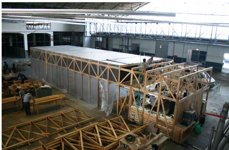
5.3 Imagem da fase de acabamentos onde já se pode ver o revestimento de plástico que protege a estrutura.
