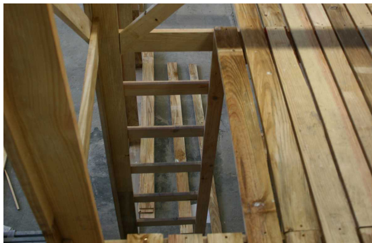
7.3 Pormenor de uma das escadas de acesso que liga a sala de estar ao quarto.
