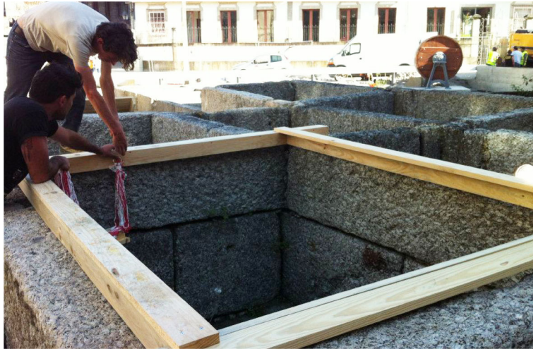
25.1 Imagem da construção de uma das estruturas associadas aos tanques.
