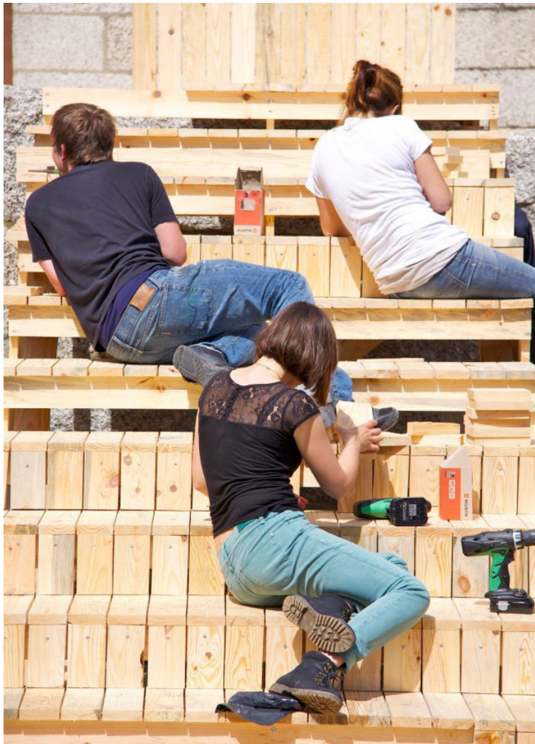
21.2 Imagem da construção da zona das escadas que faz o contacto com o interior da praça.
