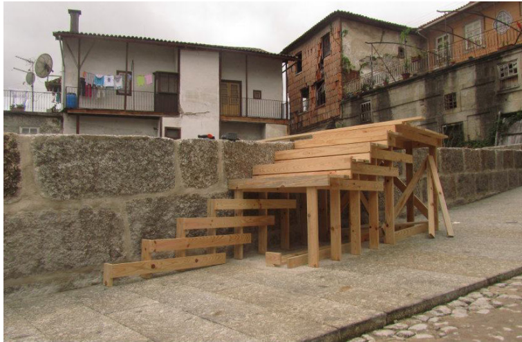
21.1 Início da construção da estrutura das escadas, neste caso da parte que faz o contacto com rua.
