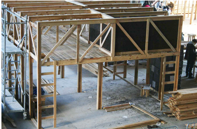
7.1 Imagem em que se podem ver os quartos situados no andar superior da estrutura.
