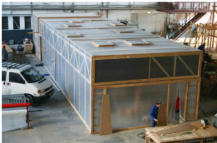
5.4 Vista aérea da área de infraestruturas praticamente completa.
