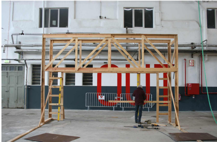
5.1 Imagem do início da construção da área de infraestruturas (cozinha, quartos, sala de estar) onde já se podem identificar os dois primeiros pórticos da estrutura.
