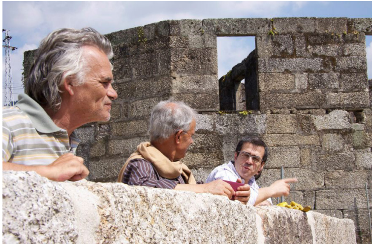
28.1 Alguns dos habitantes de Couros junto ao muro durante a construção.
