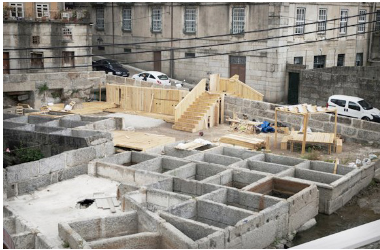
29.1 Vista geral da praça construída, a partir da Pousada da Juventude.
