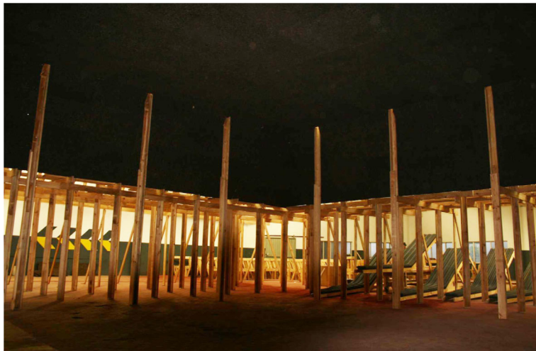
4.2 Vista interior do auditório já completo.
