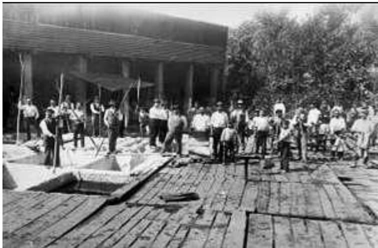
20.1 Foto onde se podem ver os tanques de lavagem de cortumes na fase em que estavam em utilização.
