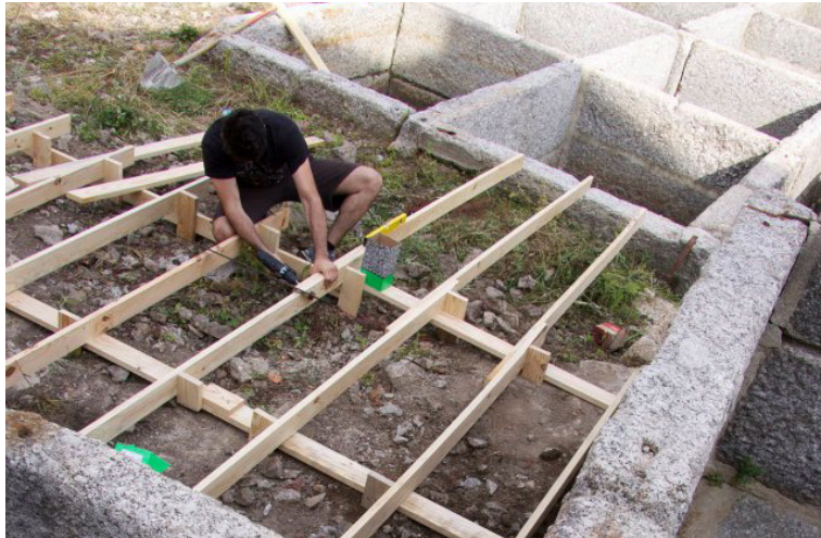
26.1 Estrutura de uma das plataformas ou palcos em início de construção.
