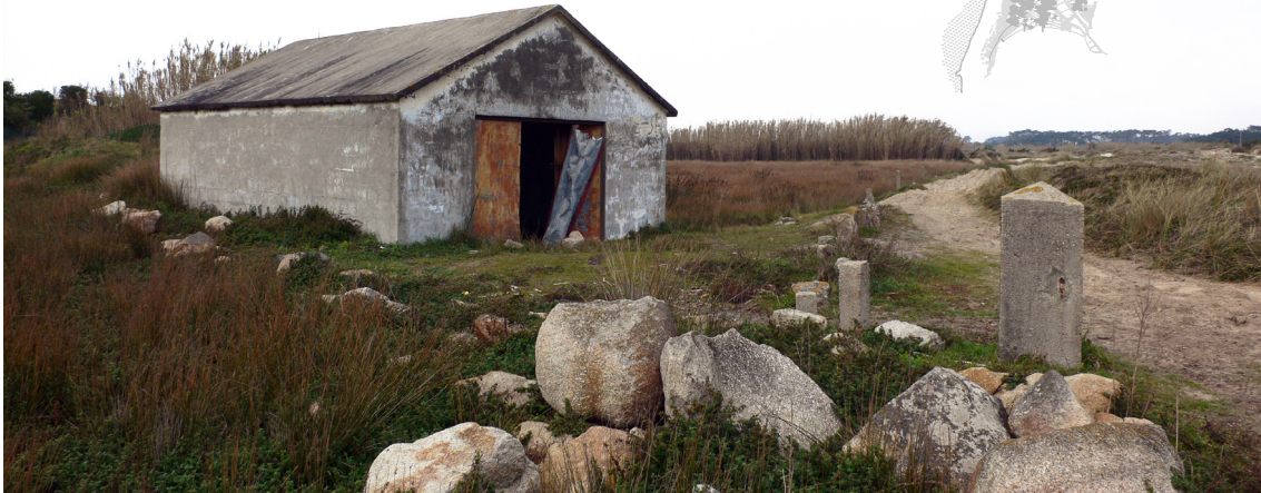
Barracão abandonado em local que antigamente foi utilizado para a agricultura e agora é utilizado como pista de motocross .
