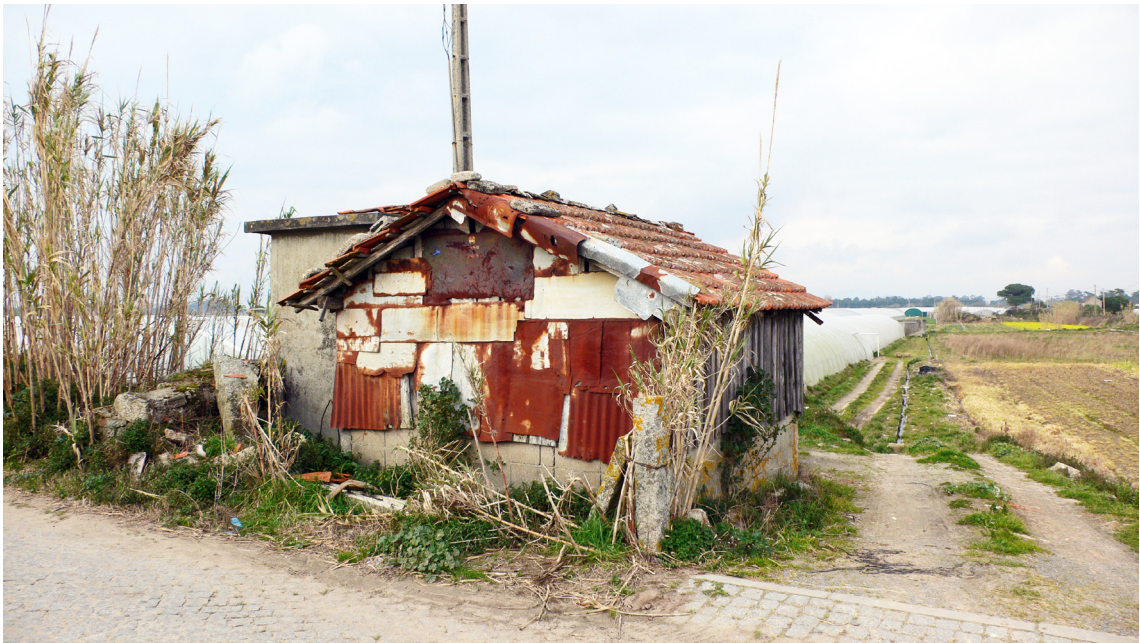
Envelhecimento dos materiais apresentados num edifício de apoio aos campos agrícolas.
