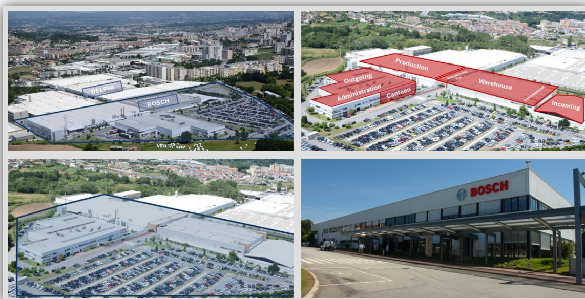
Figura 3.8 – Instalações Bosch Car Multimédia em Braga (Bosch, 2010c; Bosch, 2012c)
