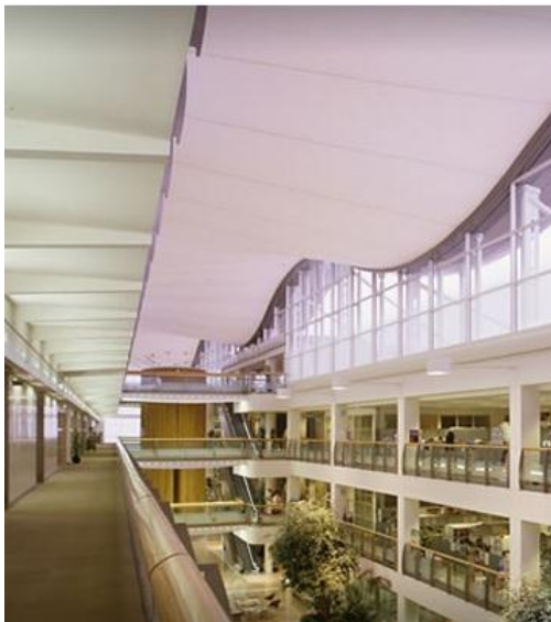
Fig. 22 – Forro com emprego do têxtil Tensotherm comercializado pela empresa Birdair. (Fonte: Birdair 2011)
