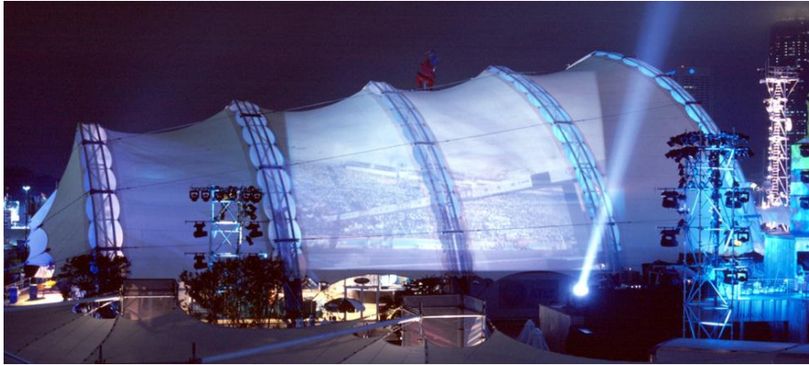
Fig. 21 – Cobertura com células fotovoltaicas. (Fonte: FLTsolar 2011)
