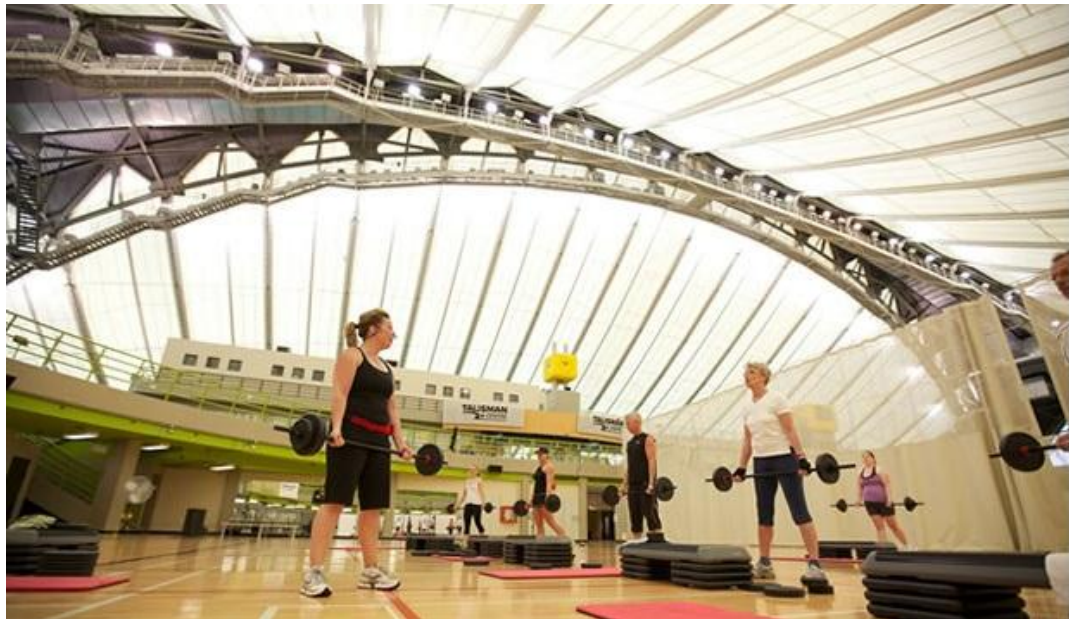
Fig. 24: Cobertura com a utilização do têxtil Tensotherm® e revestimento de nanogel Lumira™. (Fonte: Birdair 2012)
