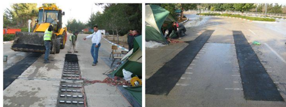
Figura 9 – Colocação do asfalto compactado sobre os geradores piezoelétricos (Innowattech, 2010)
