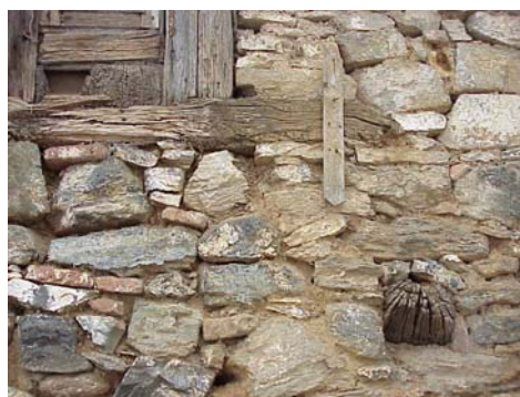
Figura 2 – Constituição típica das paredes de alvenaria
