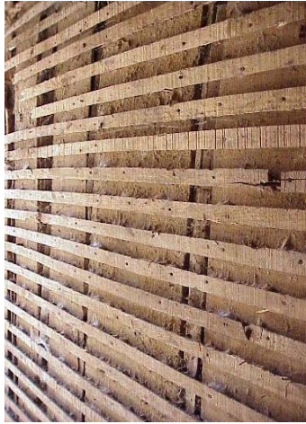
Figura 4 – Parede interior em taipa de rodízio
