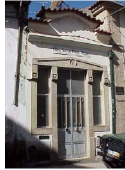
Figura 8 - Janelas em que a caixilharia de madeira foi substituída por alumínio à cor natural
