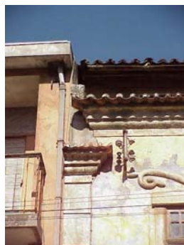
Figura 11 - Remates não respeitados devido a recuperação de um edifício contíguo
