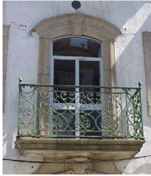
Figura 8 - Janelas em que a caixilharia de madeira foi substituída por alumínio à cor natural
