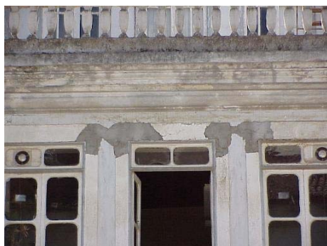
Figura 16 - Colocação de argamassas de cimento num edifício do centro histórico
