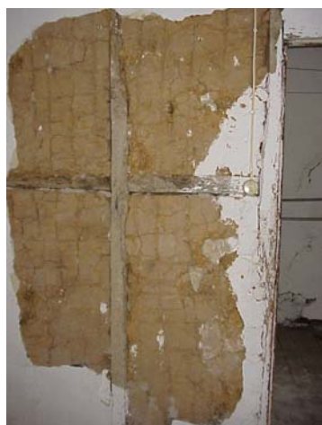
Figura 3 – Parede interior com construção tipo “Fachwerk”
