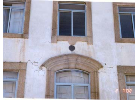
Figura 12 - Fissuração junto aos cantos de janelas
