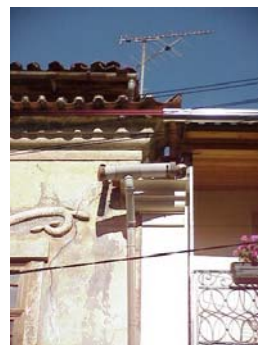
Figura 11 - Remates não respeitados devido a recuperação de um edifício contíguo
