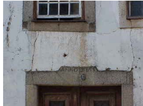
Figura 13 – Fissuração intensa
